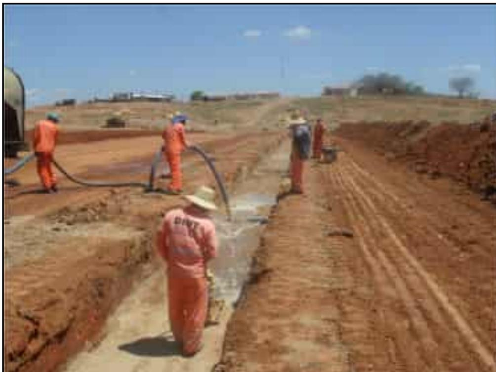
**Foto 13** – Adensamento da areia no filtro vertical com água e placa vibratória.
