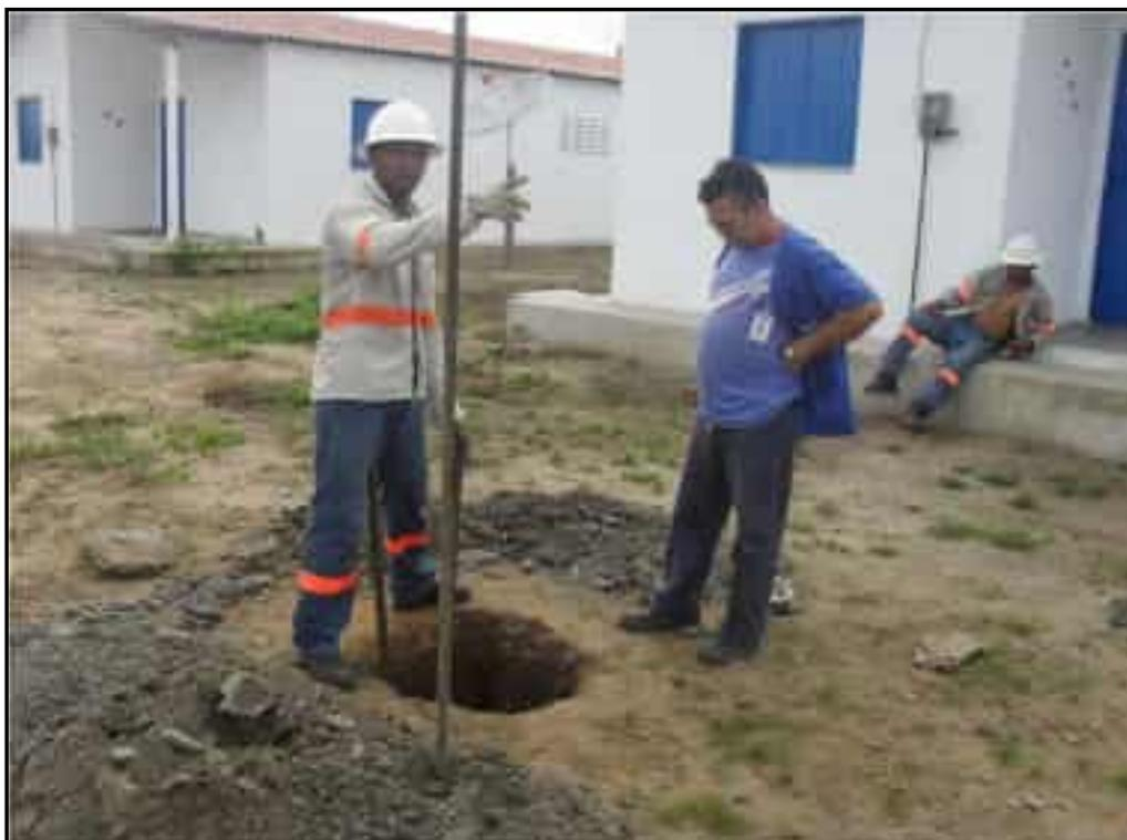
**Foto 28** – Escavação manual para implantação dos postes de eletrificação da agrovila pela Coelce.
