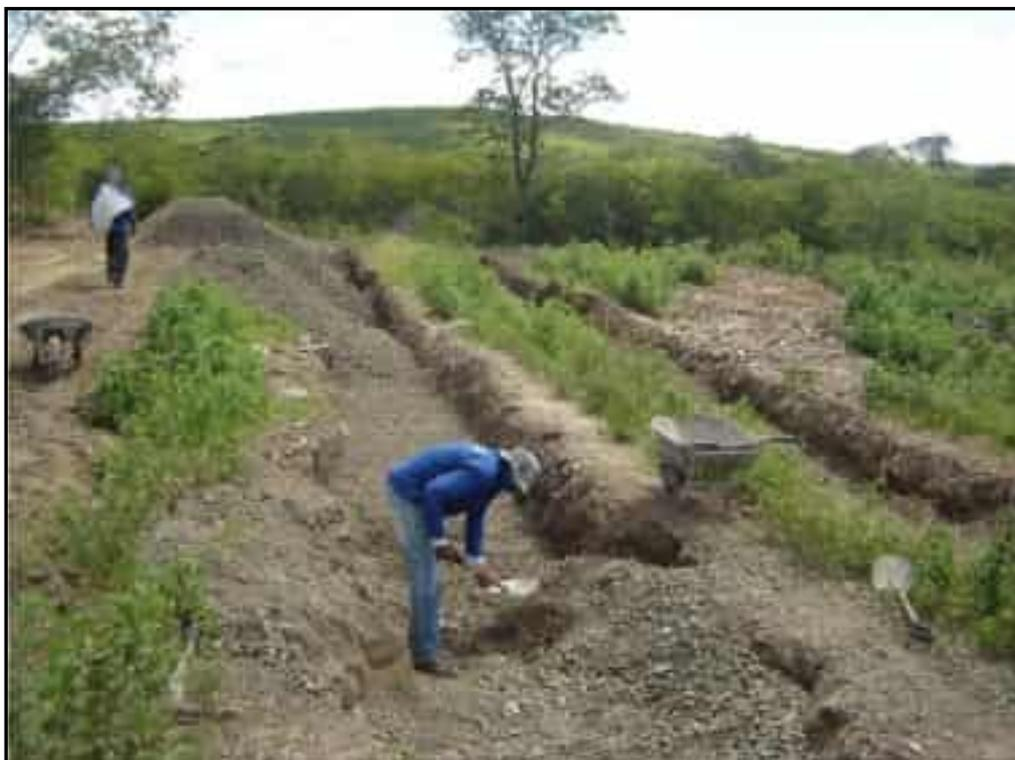
**Foto 22** – Vista do serviço de regularização com brita das valas de infiltração do sistema de esgoto da agrovila.
