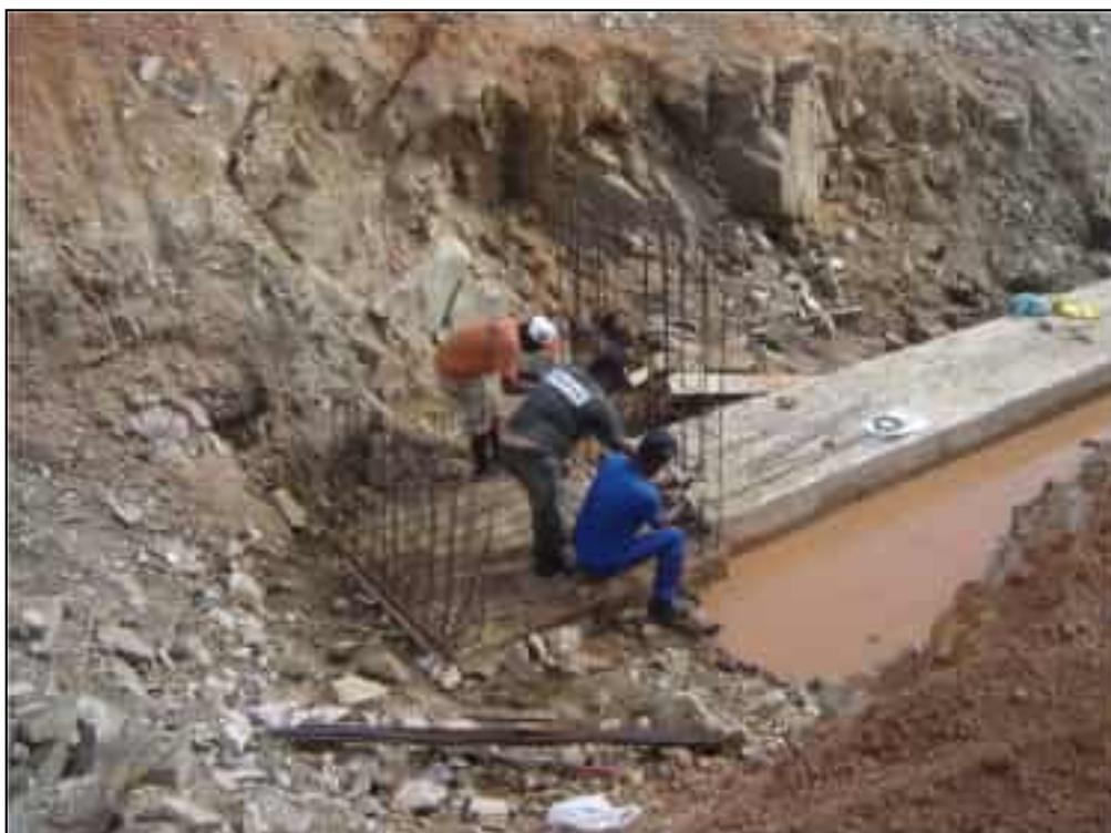
**Foto 05** – Montagem da armadura da caixa de captação da tomada d'água.
