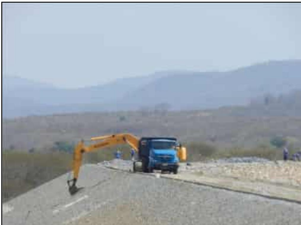
**Foto 63** – Remoção da proteção de talude de jusante para execução do letreiro com cunho paisagístico da barragem em alvenaria.
