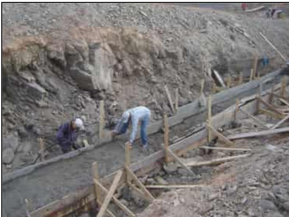
**Foto 01** – Concretagem de regularização no canal escavado da tomada d'água.
