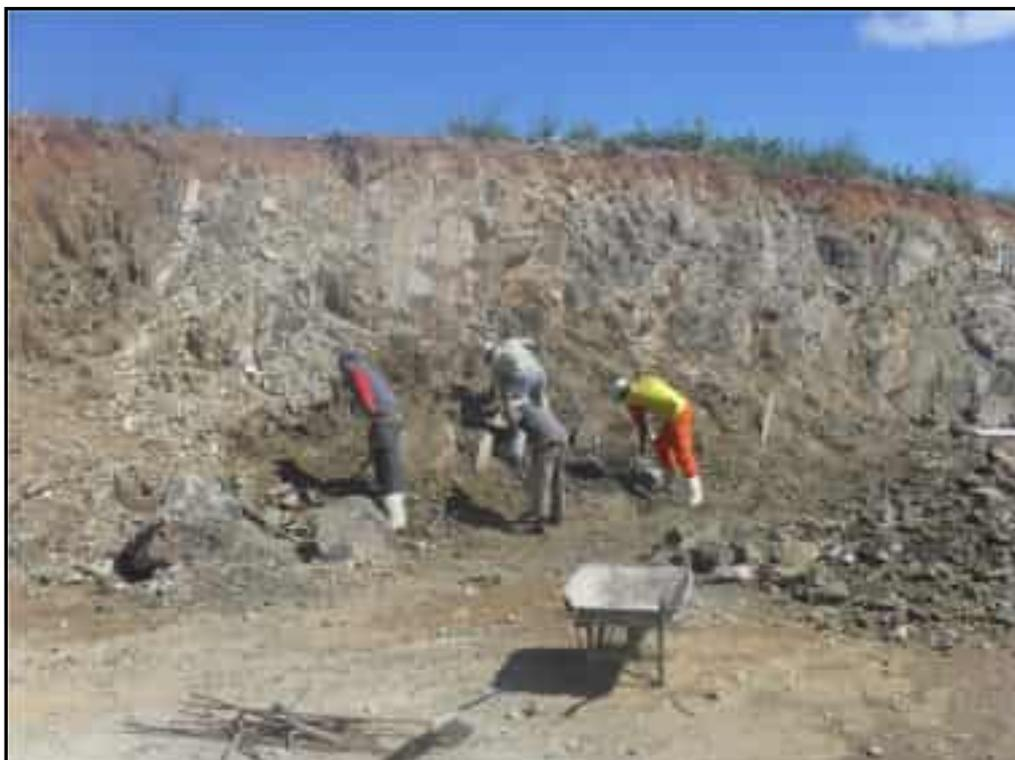
**Foto 12** – Limpeza manual da parede lateral esquerda do sangradouro para implantação do muro em concreto ciclópico.
