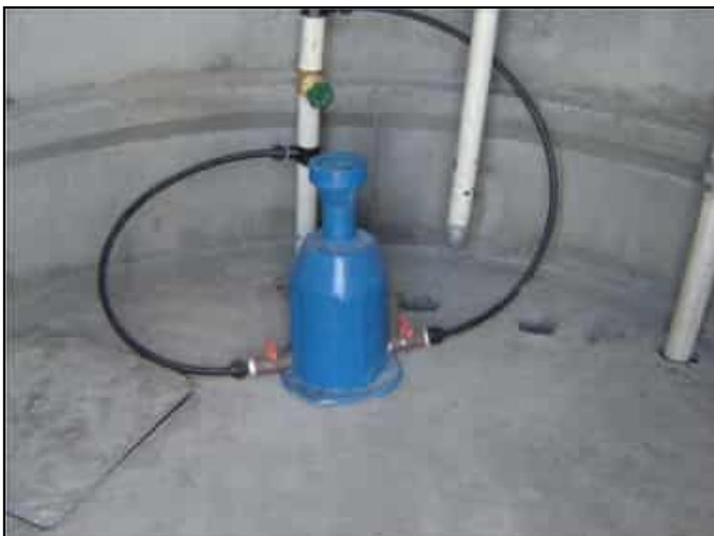
**Foto 26** – Vista do clorador de pastilha tipo Sany-Clor 5000 instalado no reservatório premoldado em concreto.
