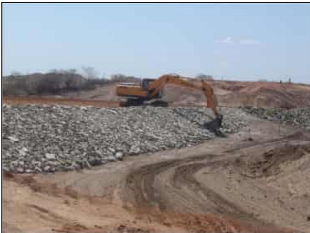
**Foto 07** – Execução e regularização do “rip-rap” entre as estacas 14+0,00 e 20+0,00.
