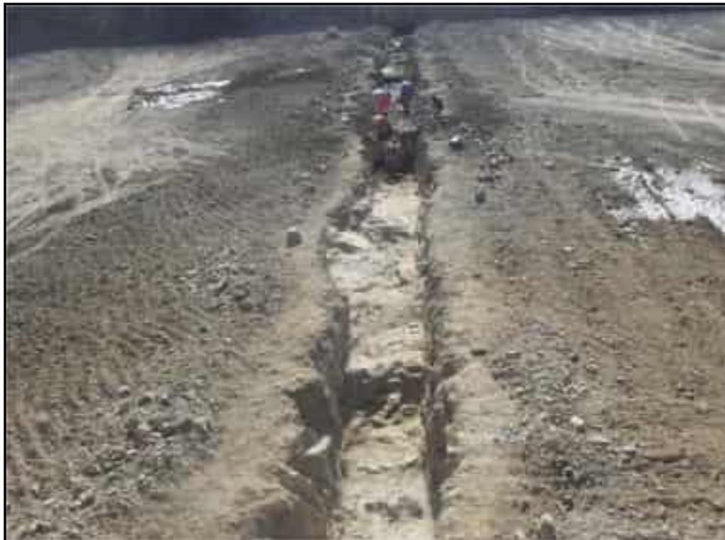
**Foto 07** – Vista longitudinal do canal escavado em rocha do cordão de fixação no sangradouro.
