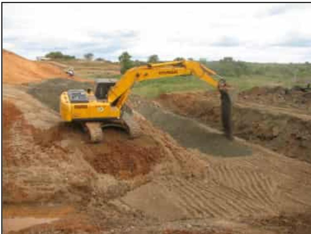
**Foto 51** – Execução do “rock-fill entre as estacas 13+10,00 e 15+0,00.
