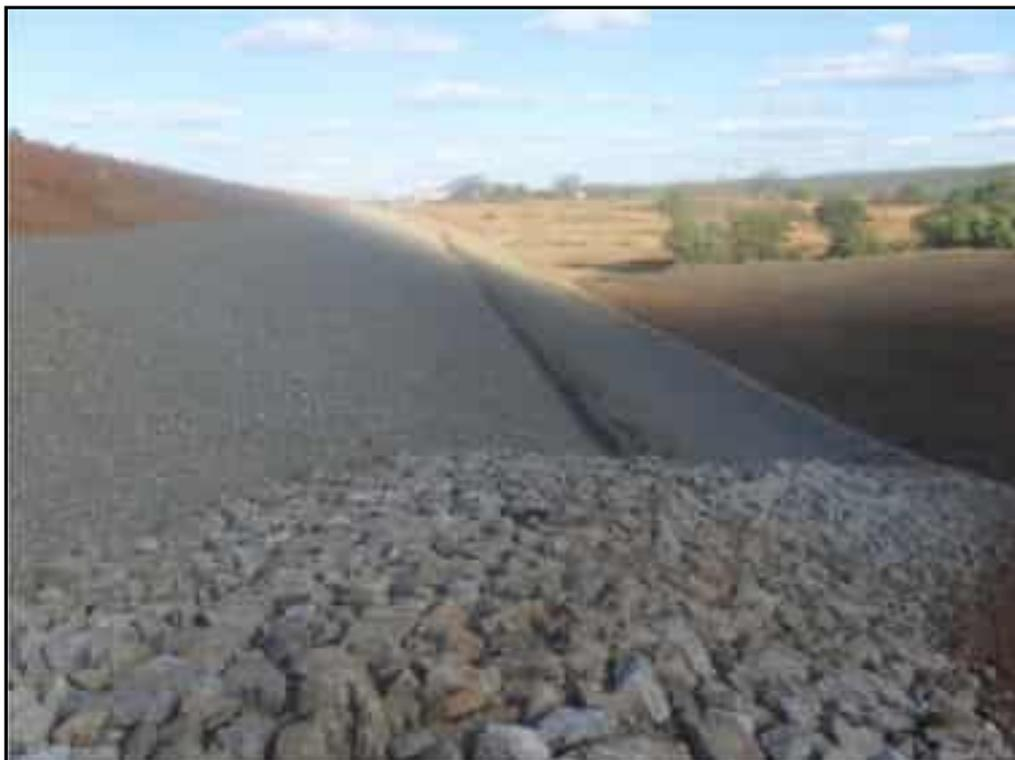
**Foto 59** – Escavação das valas de drenagem superficial na berma, cota 254,70m.
