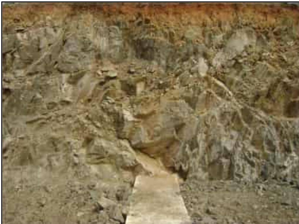
**Foto 05** – Vista do talude esquerdo do sangradouro, apresentando planos preferenciais de fraturamento, associados a planos senoidais.
