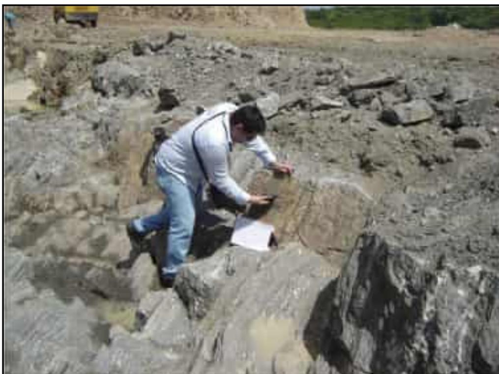
**Foto 02** – Execução do mapeamento geológico na área do cordão de fixação do sangradouro.
