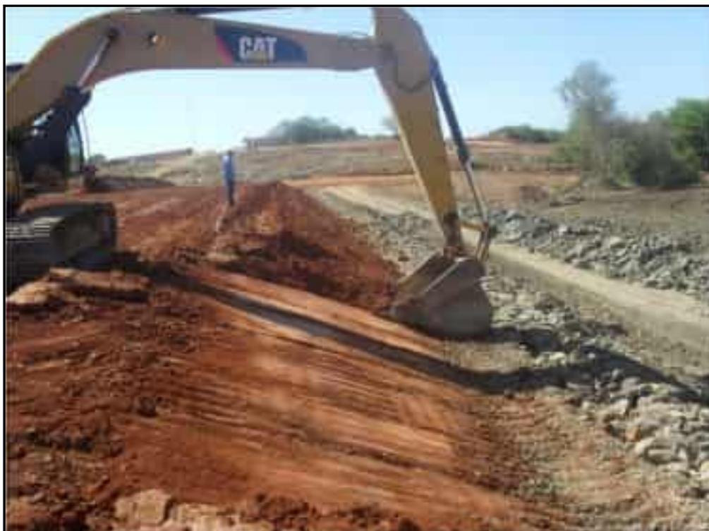
**Foto 12** – Execução do corte de rampa no talude de jusante próximo ao “rock-fill”, entre as estacas 15+0,00 e 23+0,00.
