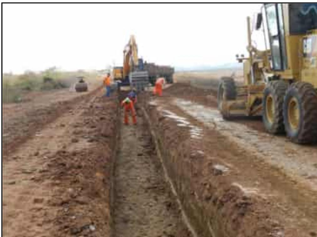
**Foto 66** – Abertura do filtro vertical entre as estacas 14E+0,00 e 23E+0,00.
