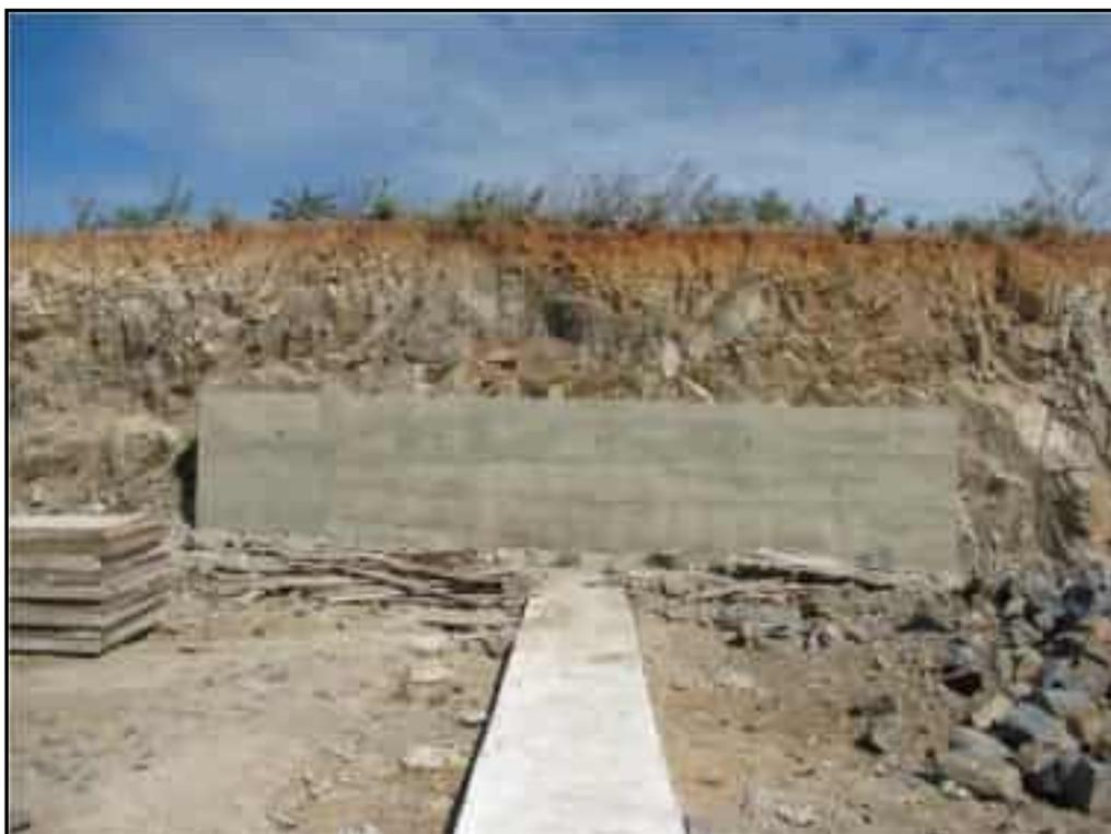
**Foto 16** – Vista do muro lateral esquerdo do sangradouro concluído.
