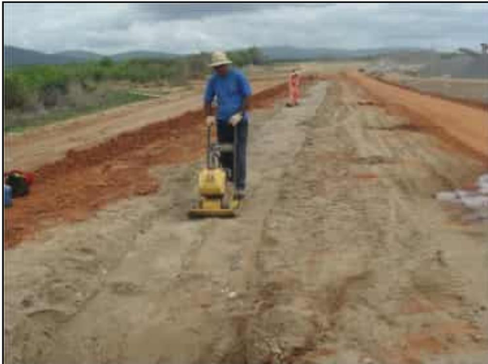
**Foto 15** – Adensamento da areia no filtro vertical entre as estacas 02A+0,00 e 10A+0,00 atingindo sua cota final na cota 261,40.
