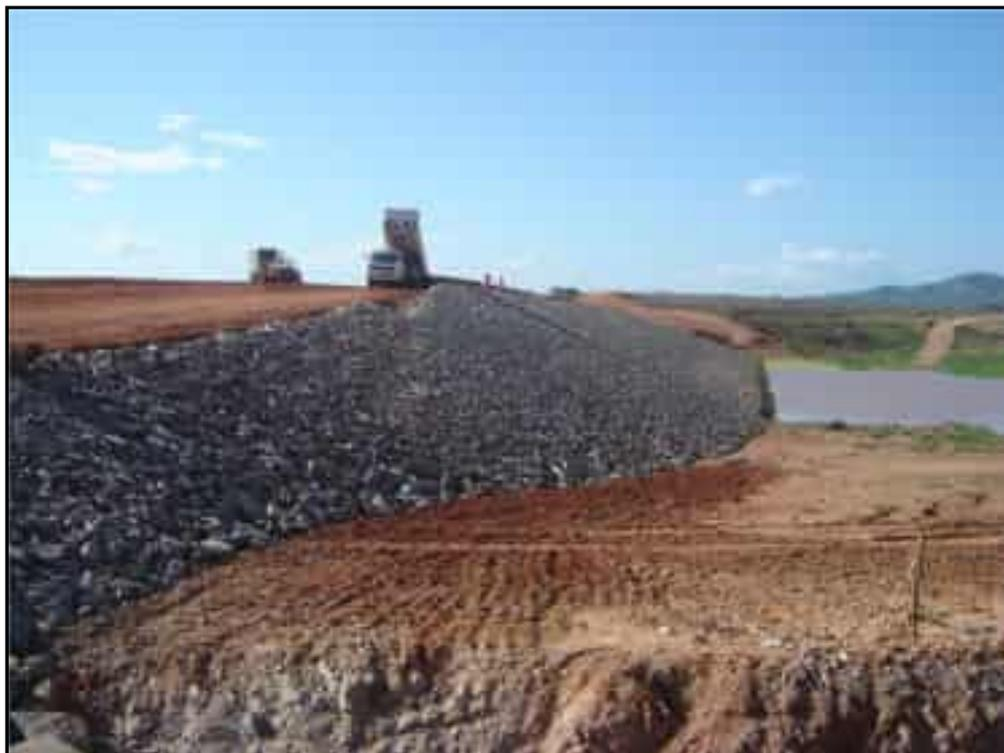
**Foto 21** – Vista longitudinal do “rip-rap” na Barragem Principal.
