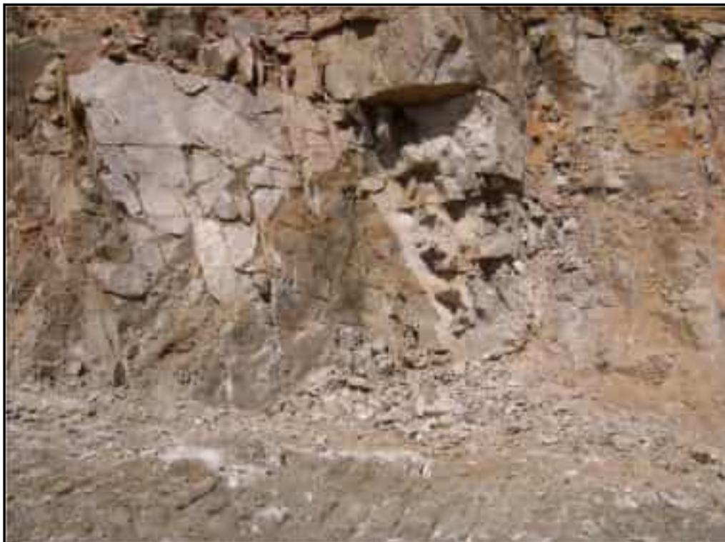
**Foto 03** – Vista do talude direito do sangradouro, apresentando dois planos preferenciais de fraturamento, associados a planos sub-horizontais de alívio.
