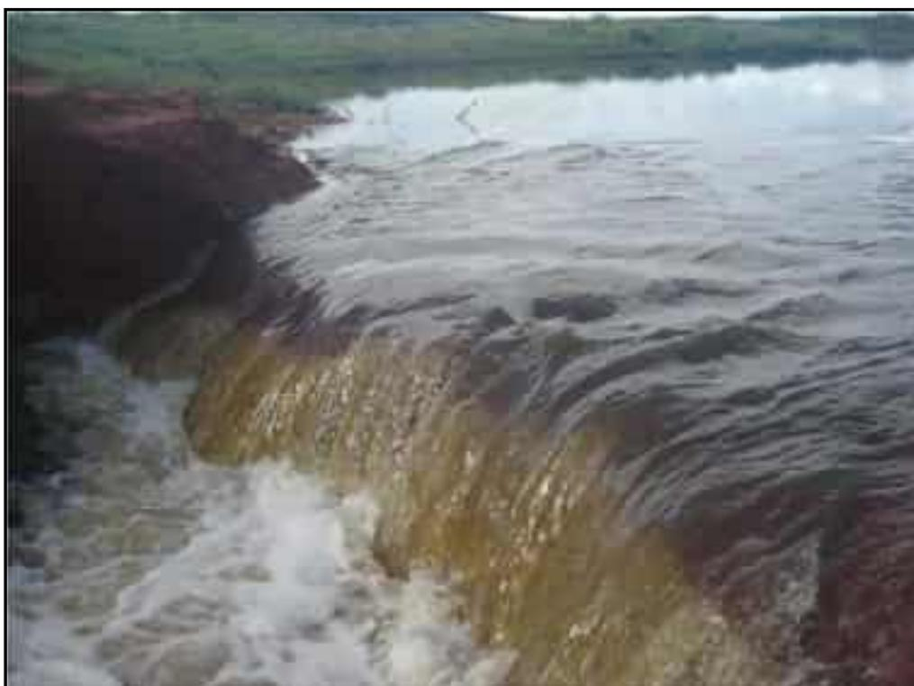
**Foto 38** – Vista da abertura no maciço localizada na estaca 13+10,00 para escoamento das águas.
