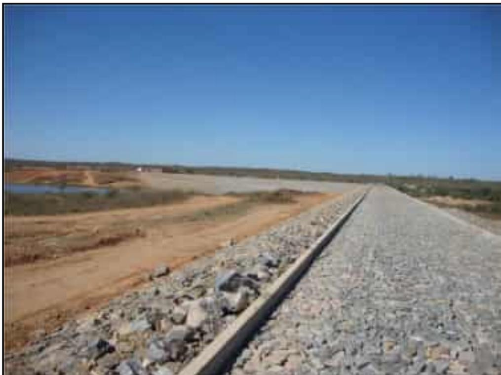
**Foto 61** – Vista longitudinal da barragem a partir da estaca 01B+0,00 e em detalhe a pavimentação em pedra tosca.
