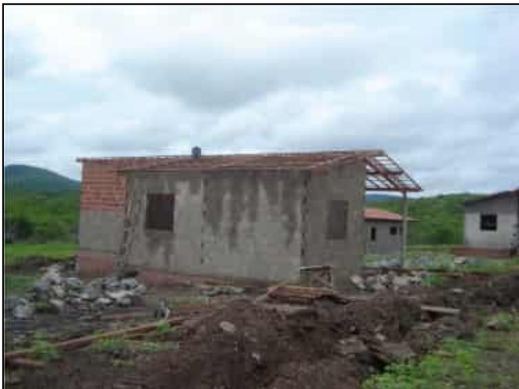
**Foto 17** – Vista da construção da casa 22 e em detalhe a execução do serviço de madeiramento da cobertura.
