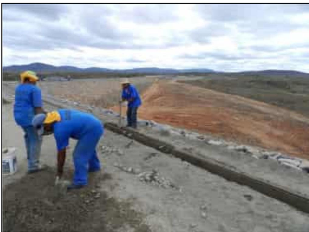
**Foto 62** – Execução do meio fio em concreto entre as estacas 10+10,00 e 29+0,00.
