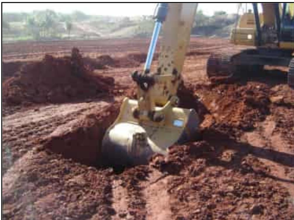
**Foto 16** – Abertura de poço de inspeção no maciço para verificação da homogeneização, compactação e umidade do material aplicado no aterro.
