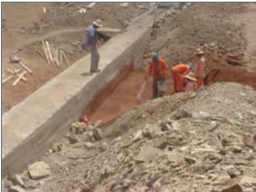
**Foto 03** – Compactação da camada de argila a cada 10cm no encontro com o concreto de regularização da tomada d'água.
