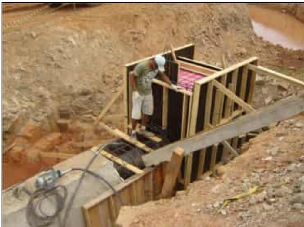
**Foto 11** – Concretagem da caixa de montante da Tomada D'Água.
