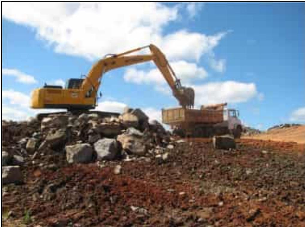
**Foto 39** – Remoção da proteção em rocha na abertura do maciço, para reinício dos serviços de aterro.
