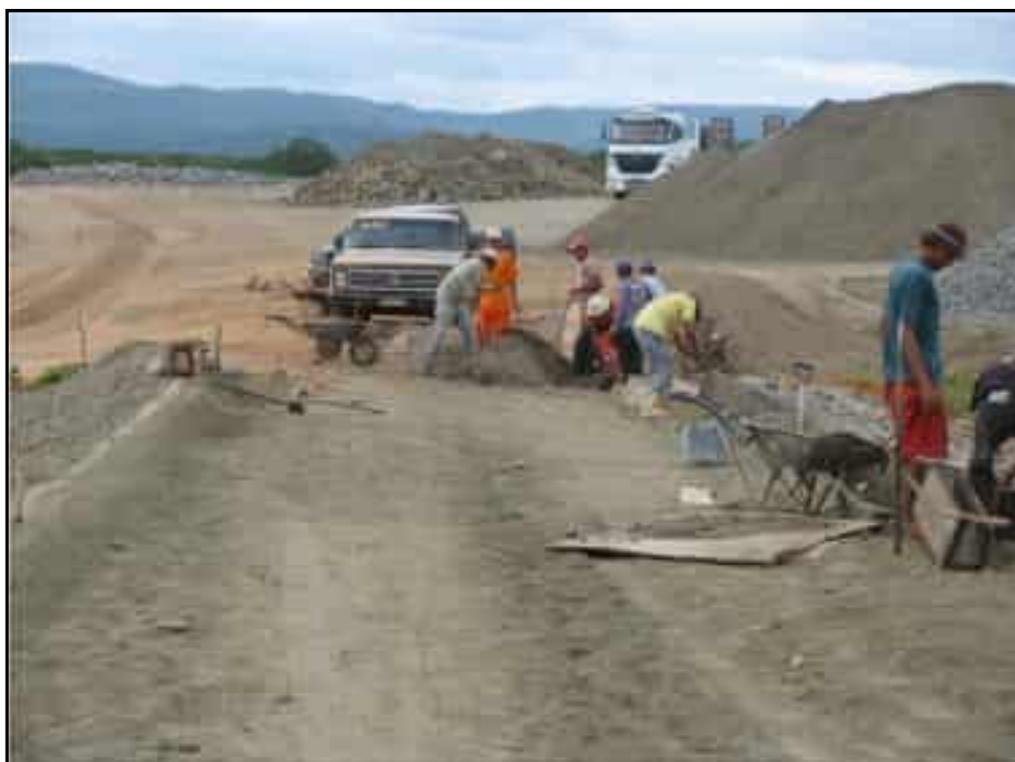
**Foto 36** – Execução de meio fio em concreto entre as estacas 02B+0,00 a 10A+0,00.
