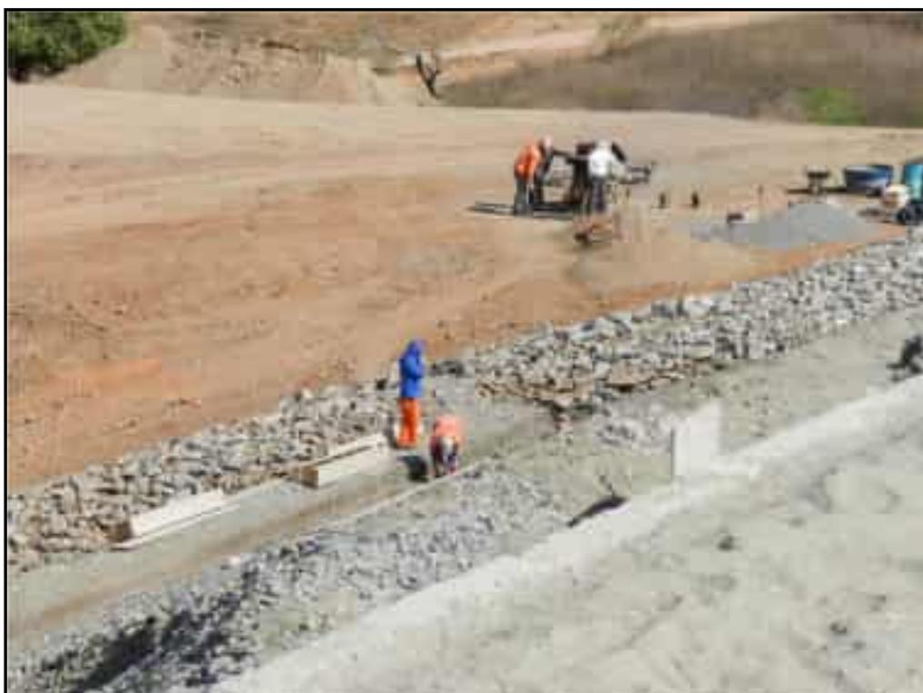
**Foto 68** – Execução da calha de drenagem de jusante na berma na estaca 14+0,00.
