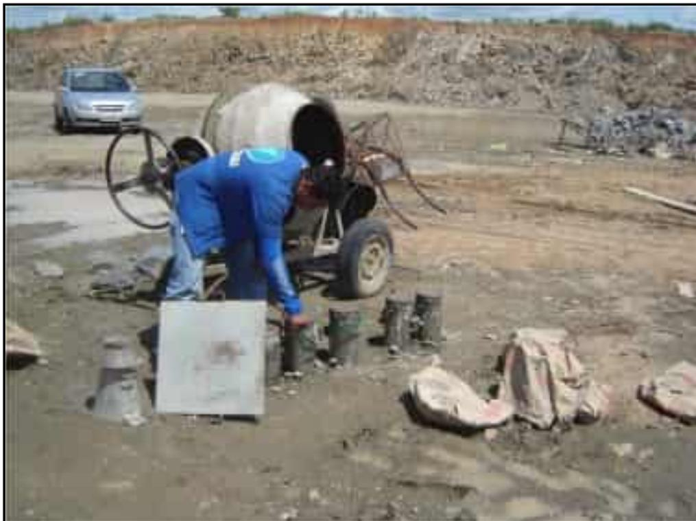
**Foto 11** – Equipe supervisora realizando moldagem de corpos de prova do concreto aplicado no cordão de fixação no sangradouro.
