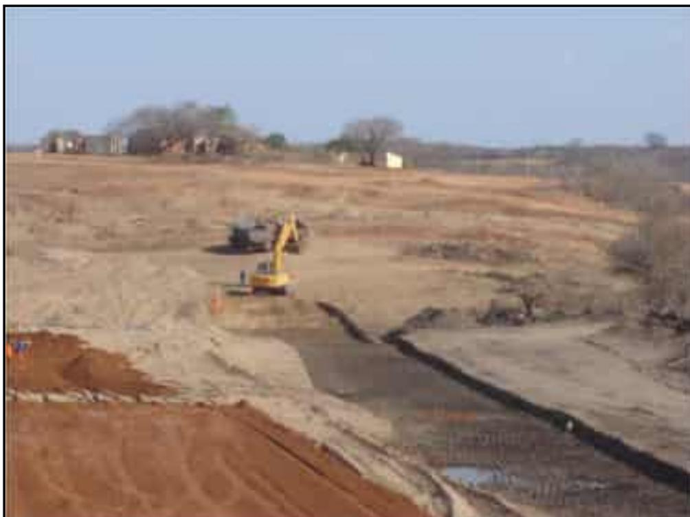
**Foto 03** – Escavação de material comum na fundação do “rock-fill”.
