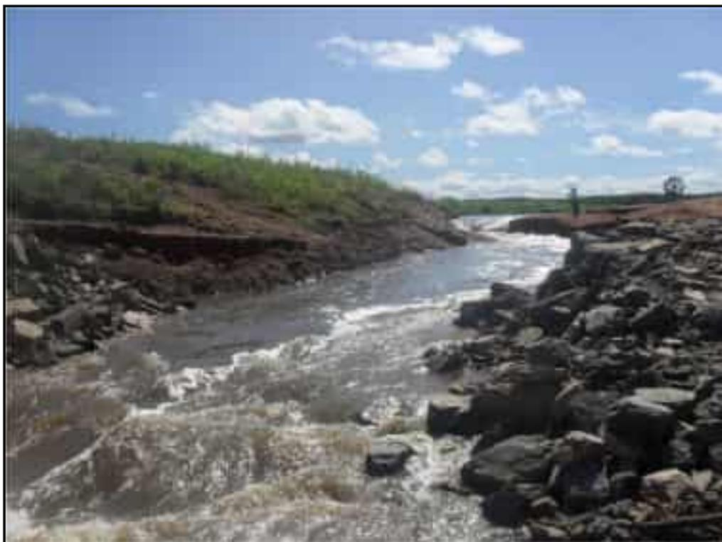
**Foto 33** – Escoamento de águas da bacia hidráulica pela abertura no maciço, conforme estabelecido.
