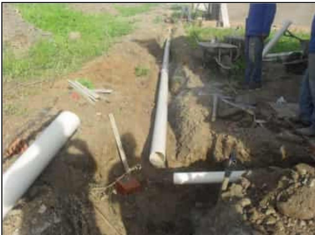
**Foto 15** – Execução do sistema de esgotamento sanitário das casas da agrovila.
