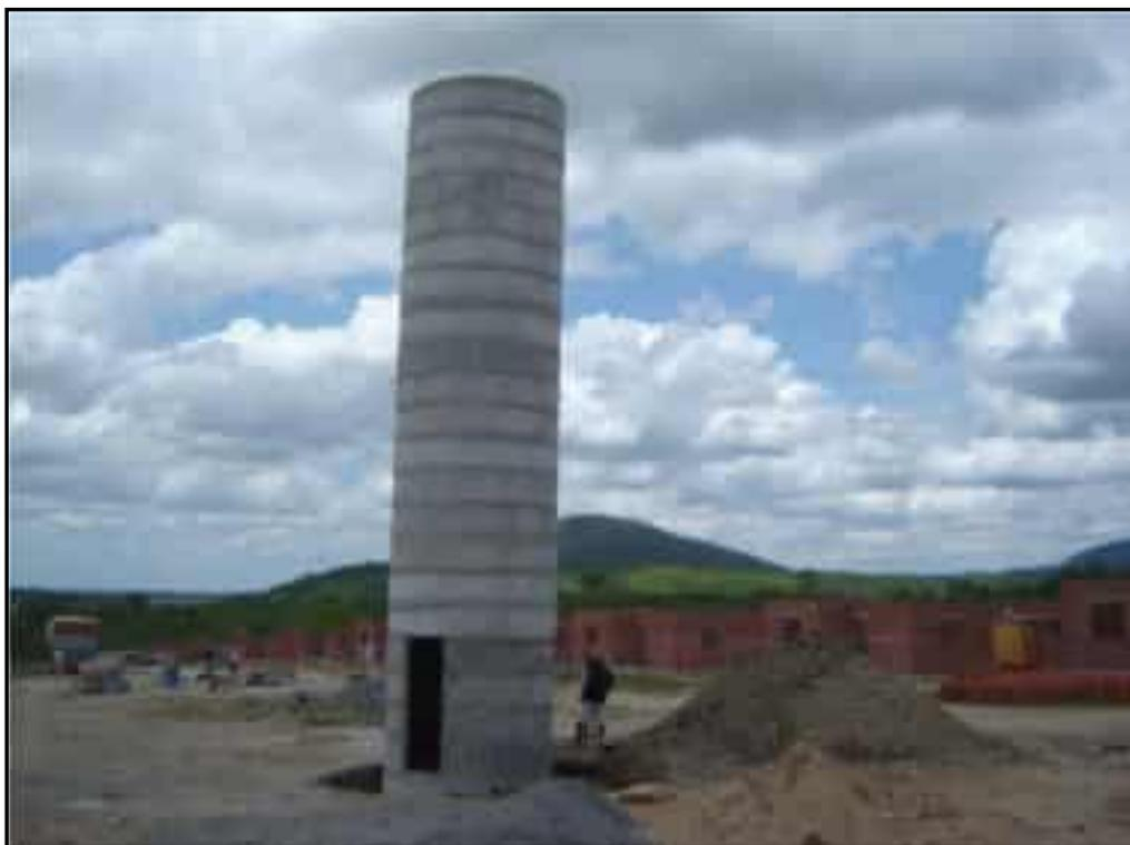
**Foto 06** – Vista da execução da caixa d'água da agrovila.
