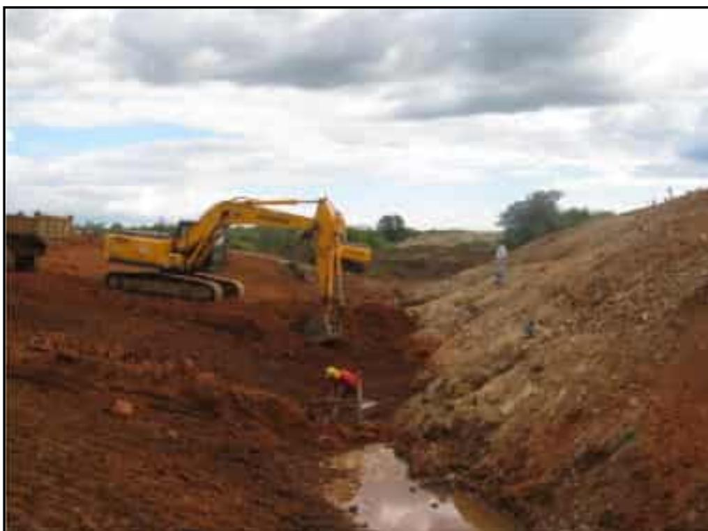
**Foto 42** – Execução de limpeza do material argiloso para reinício do aterro na estaca 13+10,00.
