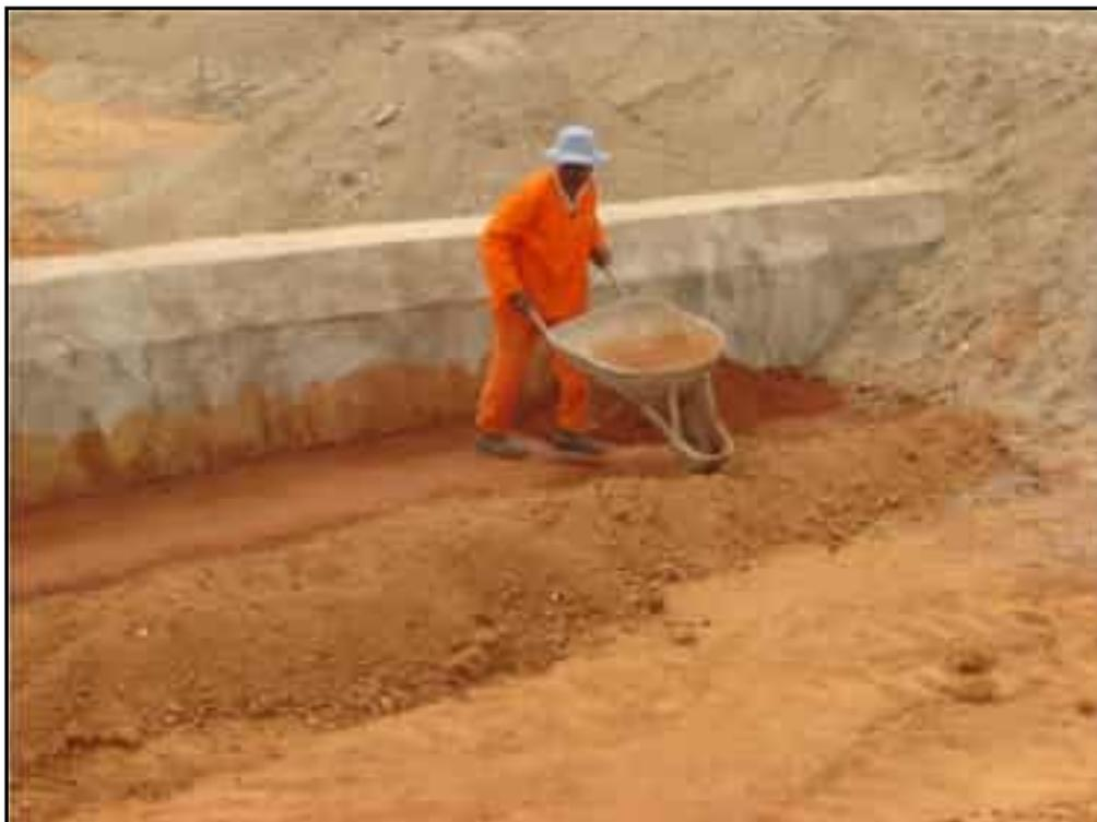
**Foto 23** – Execução do aterro compactado de argila a cada 10cm, próximo a galeria da Tomada D'Água.
