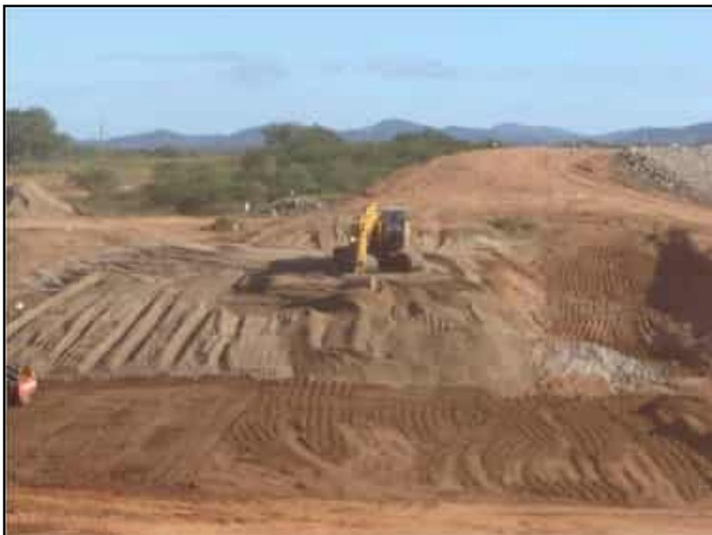
**Foto 47** – Execução do filtro horizontal entre as estacas 12+0,00 e 13+10,00.
