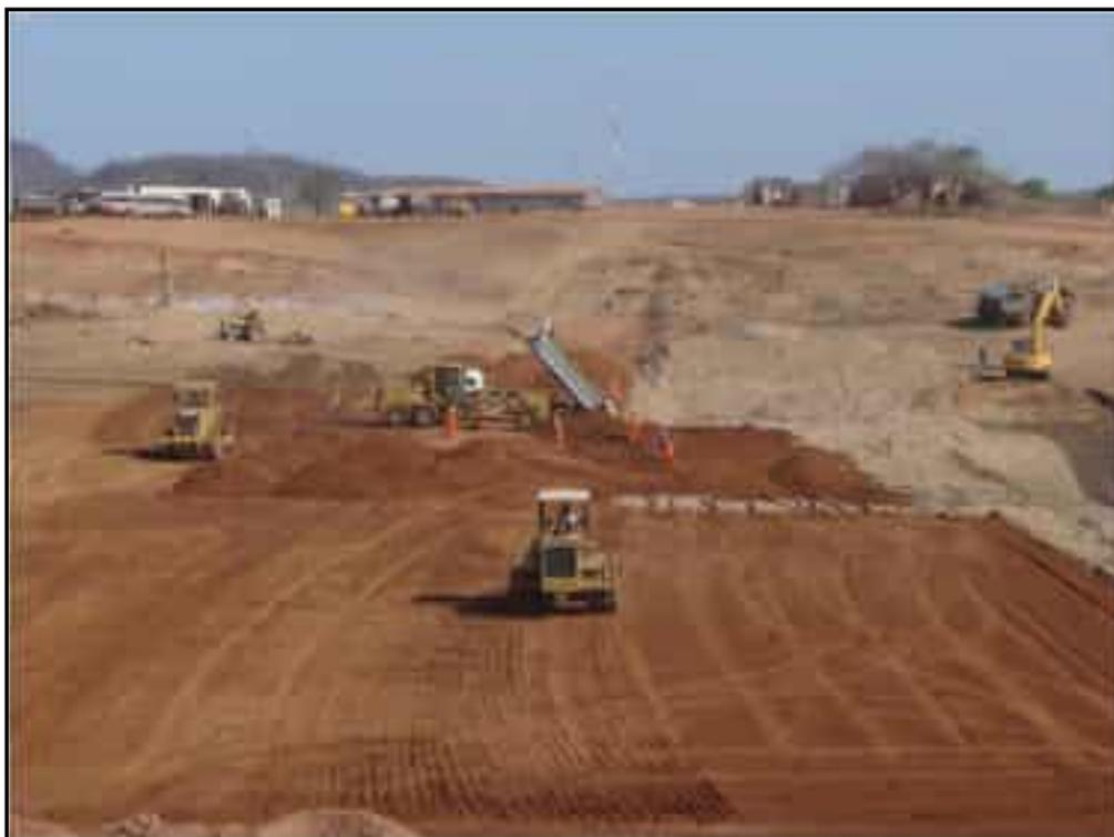
**Foto 05** – Lançamento da primeira camada de argila sobre o filtro horizontal entre as estacas 19+0,00 e 22+0,00.
