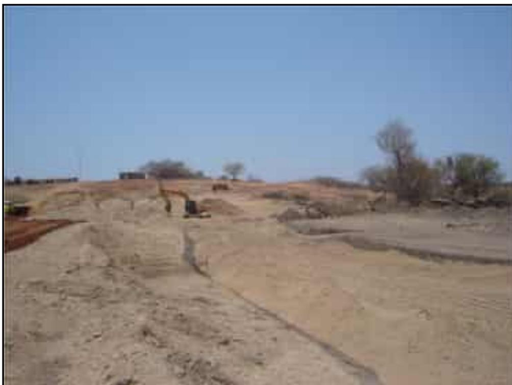
**Foto 04** – Execução da zona 7, dreno de areia, na fundação do “rock-fill”.
