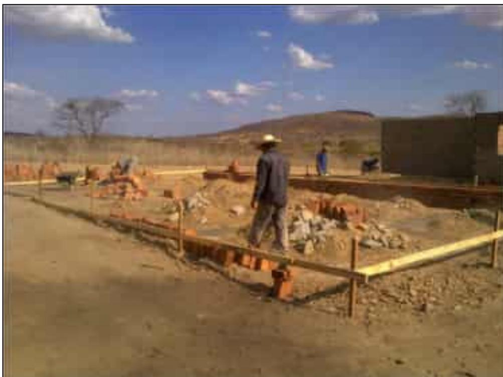
**Foto 01** – Vista da execução da fundação da alvenaria de elevação e em detalhe a marcação do gabarito.
