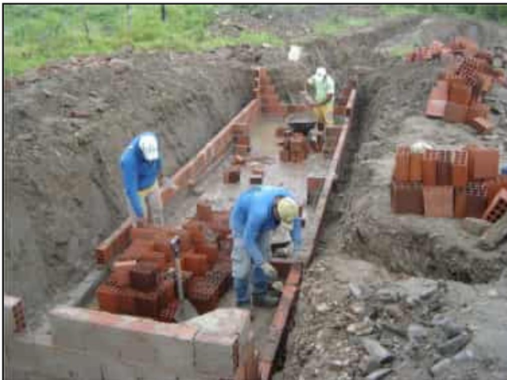
**Foto 13** – Construção em alvenaria de tijolo cerâmico da primeira fossa séptica da agrovila.
