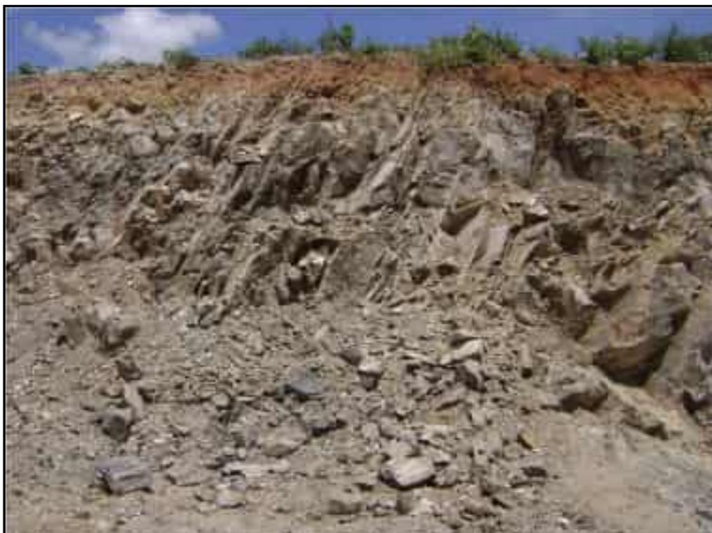
**Foto 06** – Planos preferenciais de fraturamento, associados a planos sub-horizontais de alívio e senoidais, ocasionando desmoronamentos de blocos de tamanhos diversos para o interior do canal.
