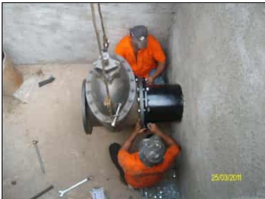
**Foto 14** – Vista do serviço de montagem do registro de gaveta da tomada d'água.
