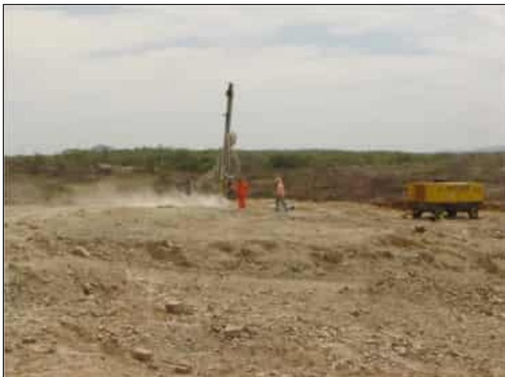
**Foto 02** – Perfuração em rocha para detonação no canal de aproximação do sangradouro.
