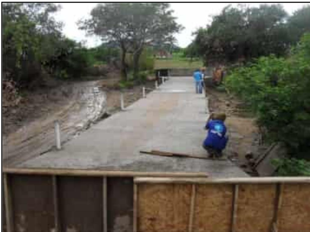
**Foto 03** – Construção da passagem molhada na estrada entre a barragem e a cidade de Baixo/CE.
