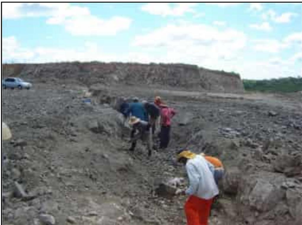
**Foto 08** – Execução do serviço de limpeza manual no canal escavado do cordão de fixação no sangradouro.
