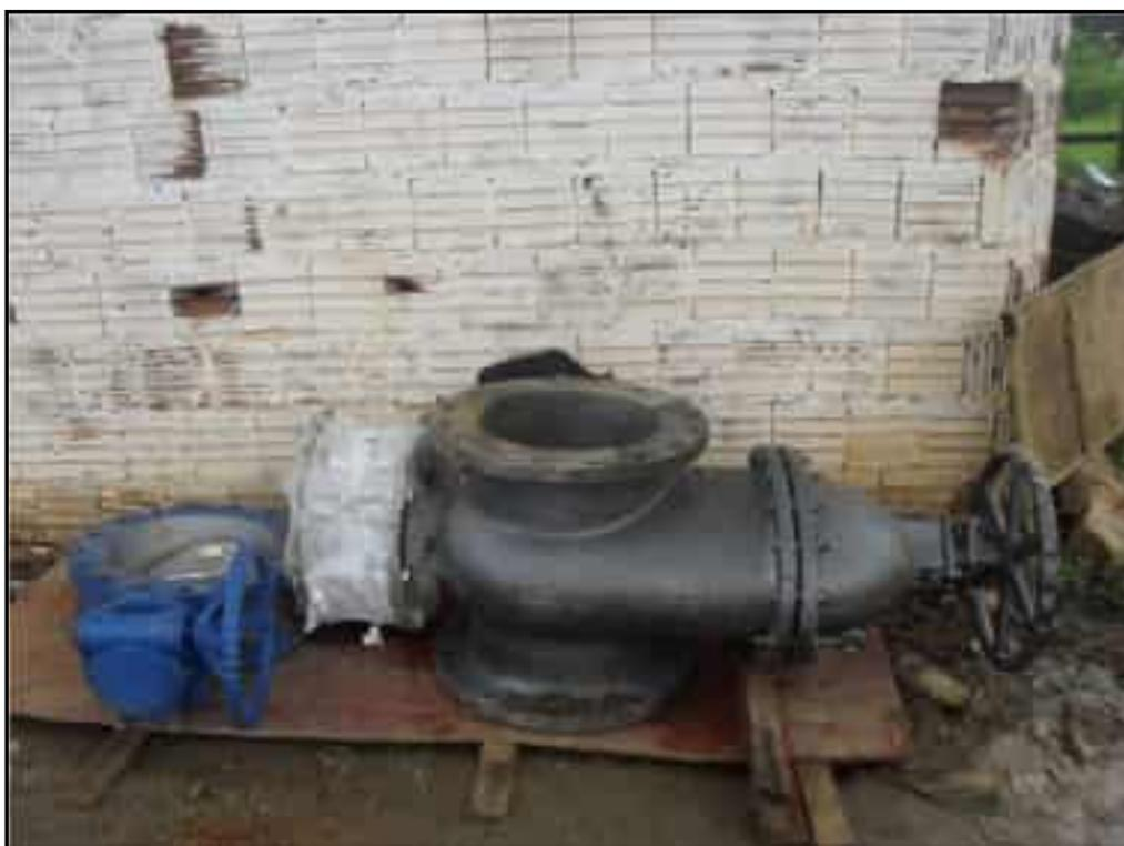
**Foto 12** – Vista do registro de gaveta e da válvula borboleta da caixa de saída da Tomada D'água.
