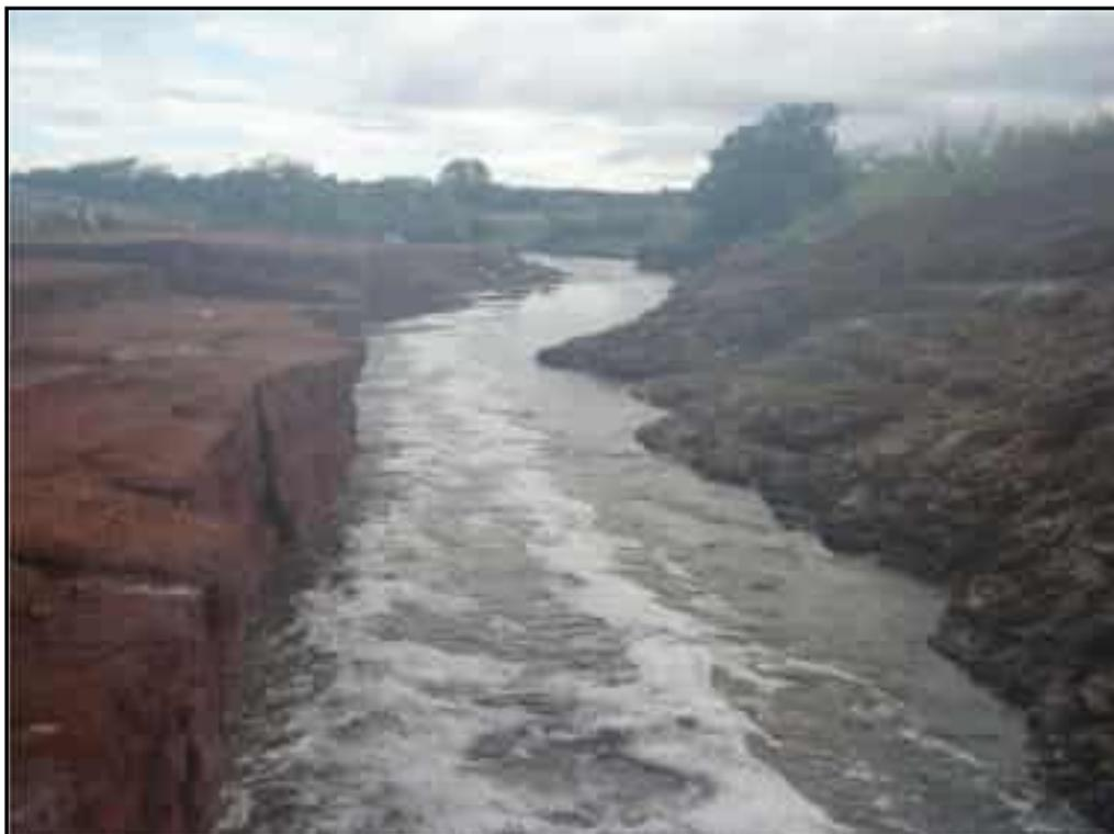
**Foto 37** – Vista longitudinal da abertura no maciço na estaca 13+10,00 e em detalhe o escoamento de águas da bacia hidráulica.
