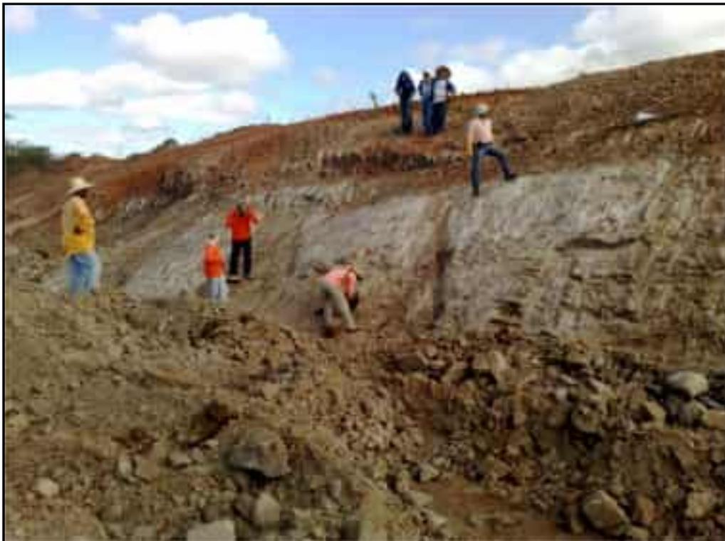
**Foto 43** – Limpeza manual da rocha para execução do aterro.
