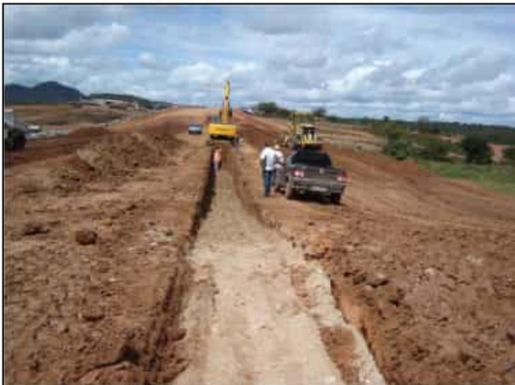
**Foto 49** – Abertura do filtro vertical entre as estacas 12+0,00 e 16+0,00.
