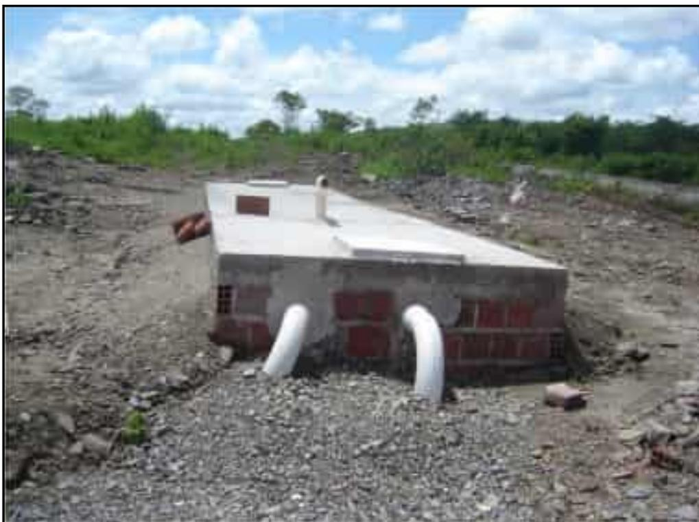
**Foto 20** – Vista da primeira fossa séptica concluída e em detalhe as ligações para as valas de infiltração.
