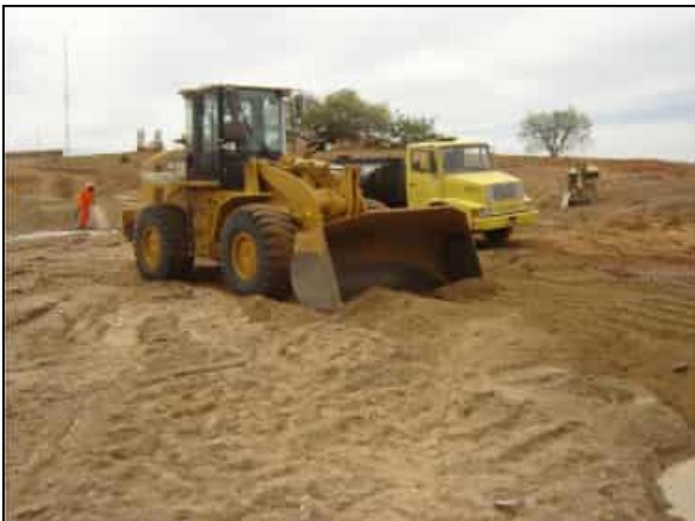
**Foto 22** – Espalhamento e adensamento do filtro horizontal entre as estacas 24+0,00 e 26+0,00.
