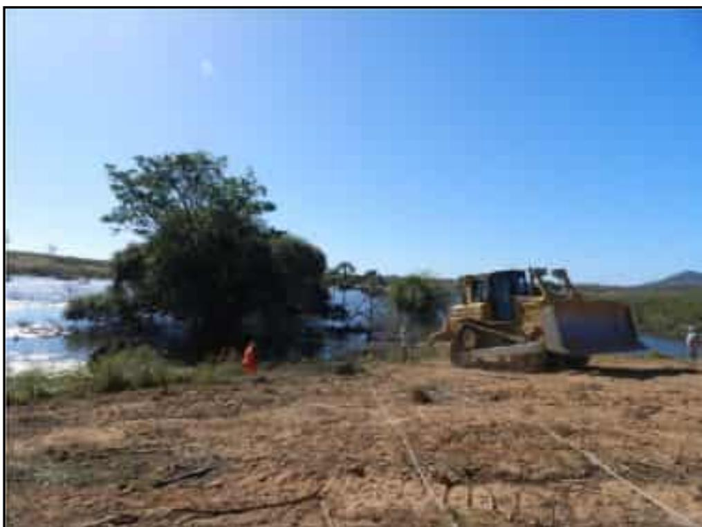
**Foto 04** – Remoção de árvores de grande porte próximo ao eixo do barramento.
