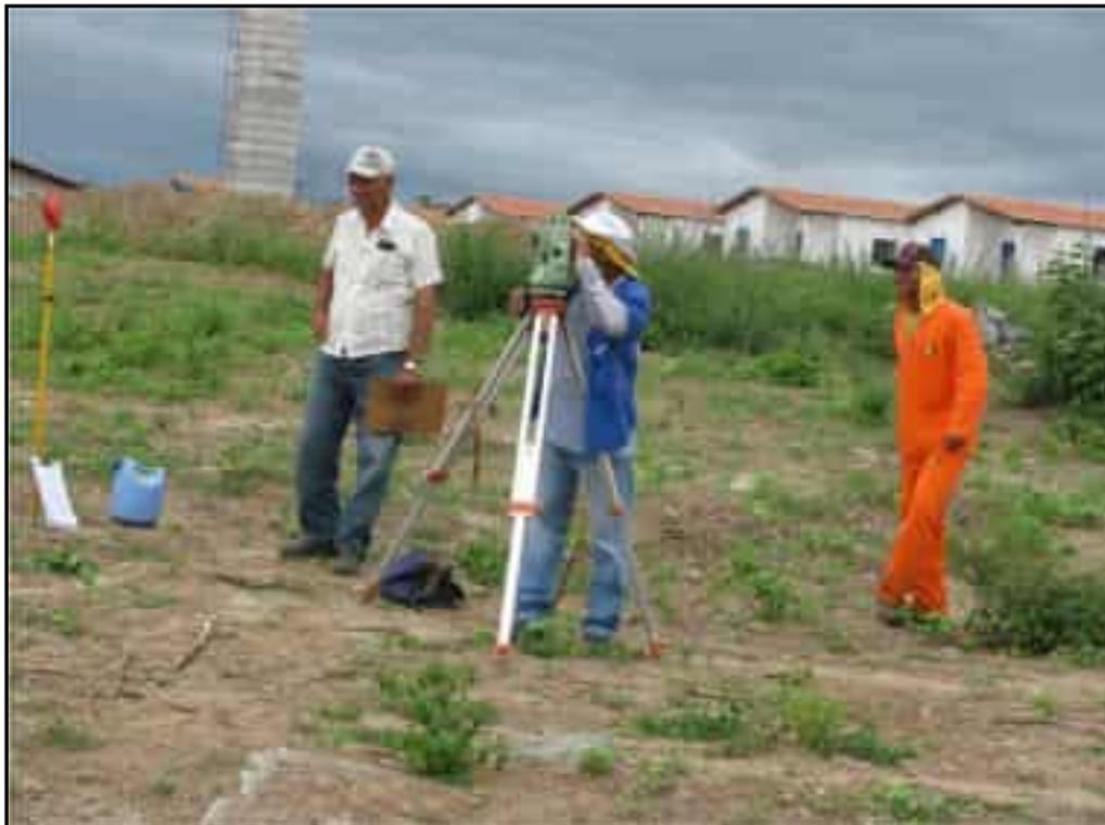
**Foto 27** – Equipe supervisora realizando levantamento topográfico na agrovila.
