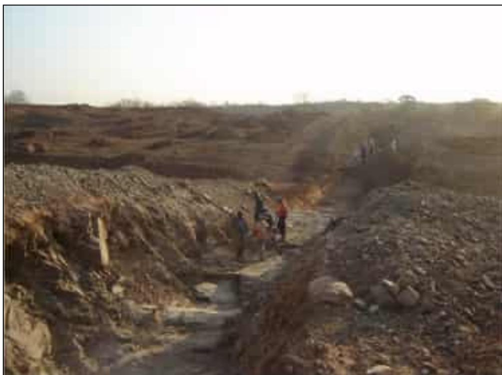
**Foto 02** – Limpeza manual do canal escavado da tomada d'água na est. 24.
