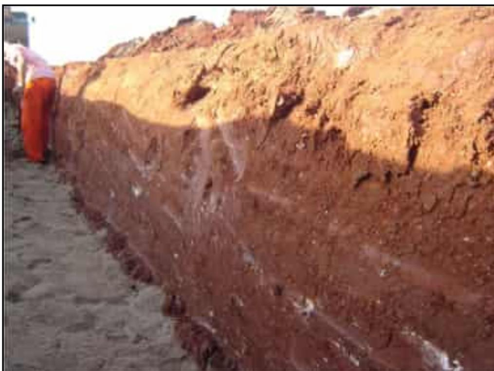
**Foto 26** – Vista do corte no aterro onde observou-se uma boa qualidade na compactação das camadas de argila.
