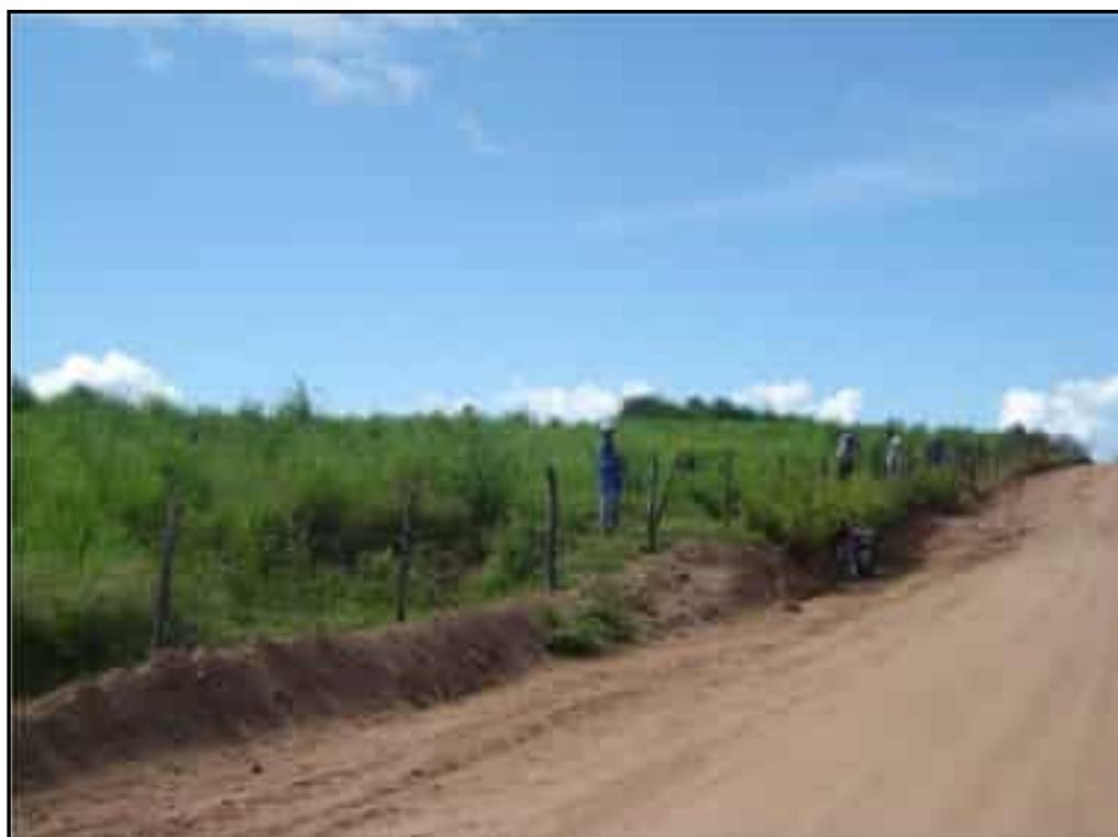
**Foto 08** – Montagem de cercas com estaca da madeira e 6 fios de arame farpado na estrada de contorno entre a barragem e a cidade de Baixo/CE.
