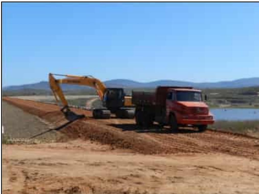
**Foto 55** – Execução da regularização do talude de jusante na estaca 28+0,00.
