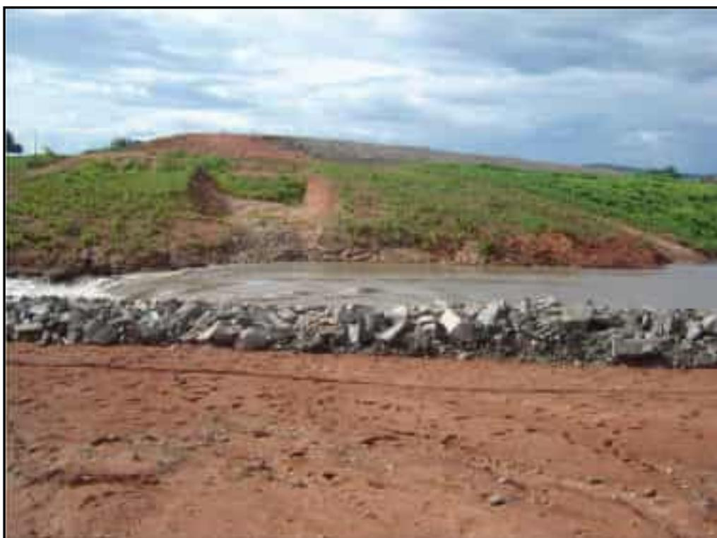
**Foto 34** – Vista do escoamento das águas na abertura do maciço na estaca 14+0,00 após a ocorrência de fortes chuvas.
