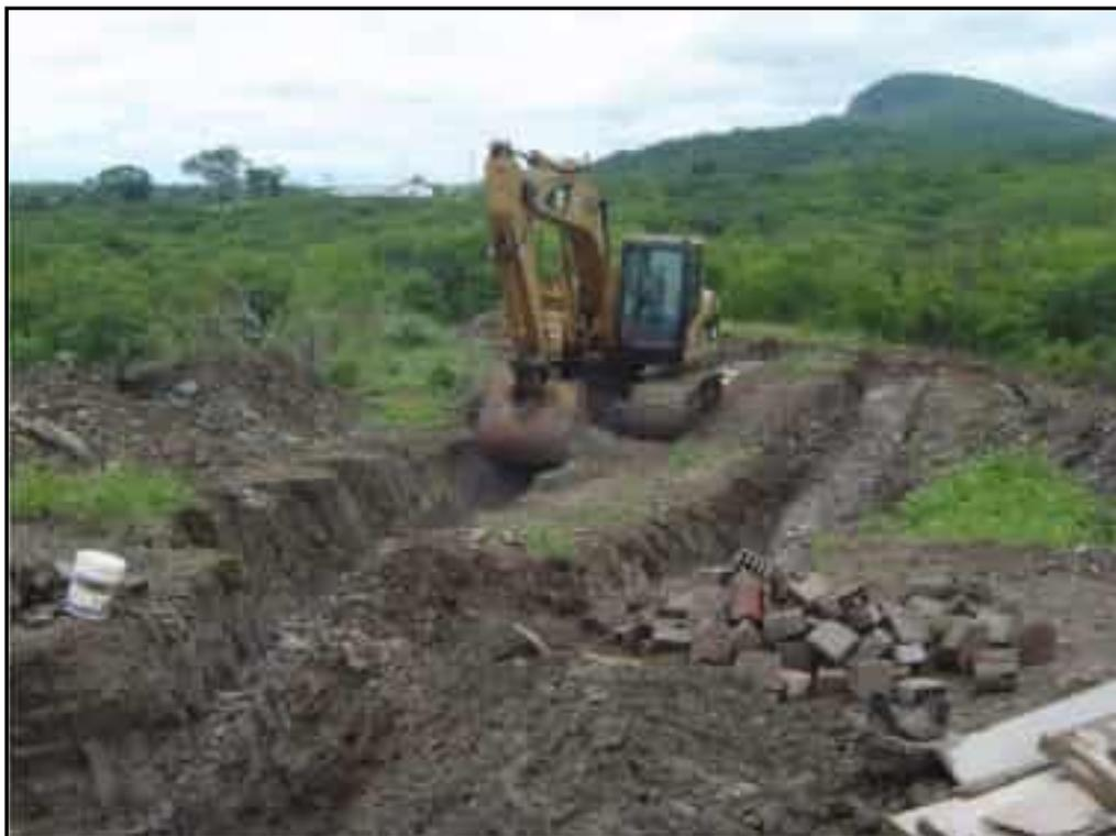
**Foto 11** – Escavação mecânica das valas de infiltração do sistema de esgoto da agrovila.
