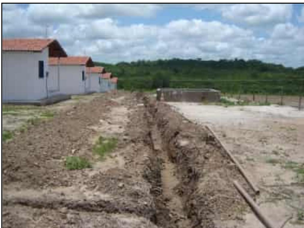
**Foto 12** – Escavação das valas do sistema de distribuição de água na agrovila.
