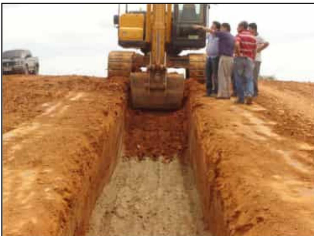
**Foto 24** – Abertura do filtro vertical entre as estacas 16+10,00 a 20+0,00.
