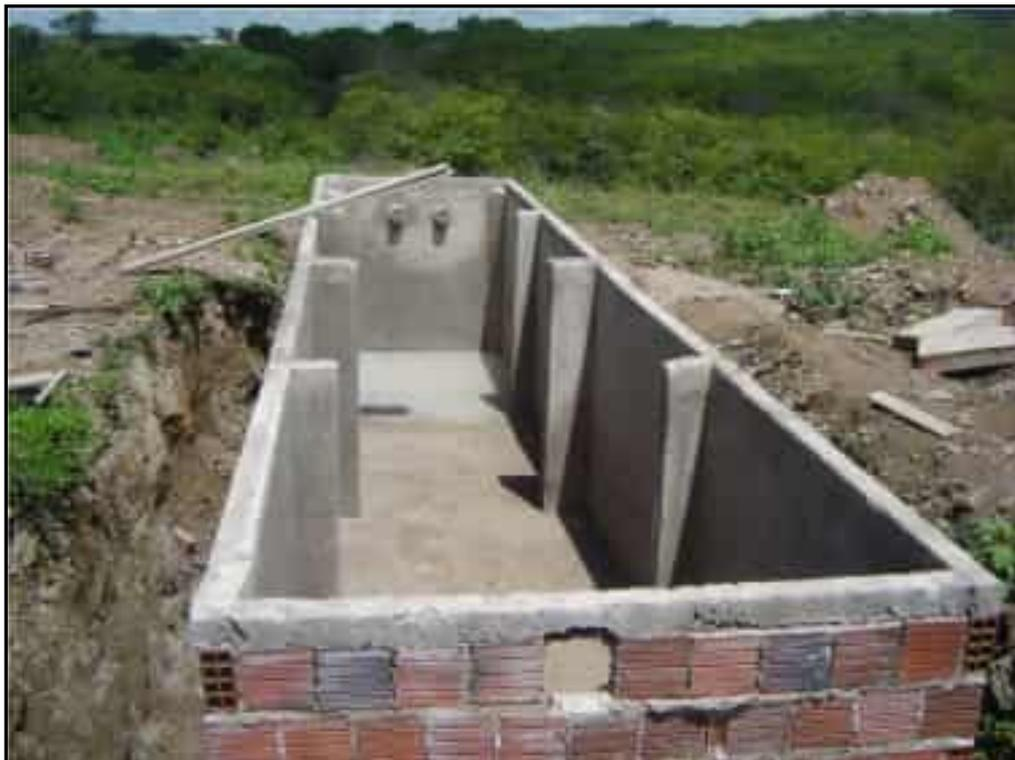
**Foto 21** – Construção em alvenaria de tijolo cerâmico da segunda fossa séptica da agrovila.
