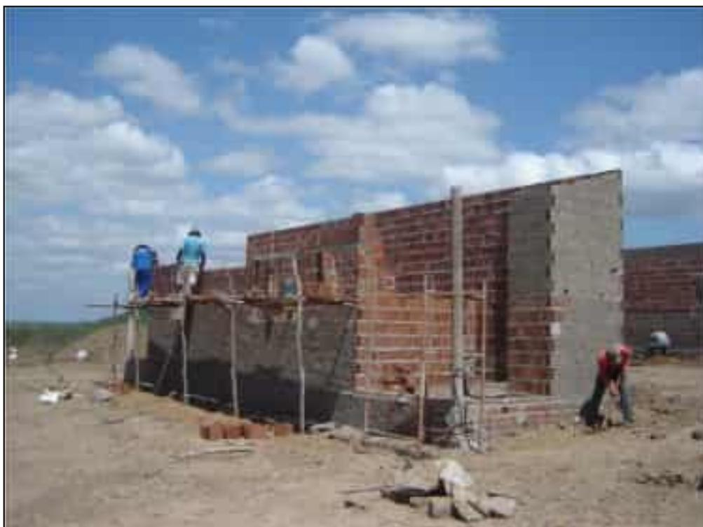
**Foto 02** – Execução do serviço de alvenaria de elevação das unidades habitacionais na agrovila com tijolos cerâmicos.
