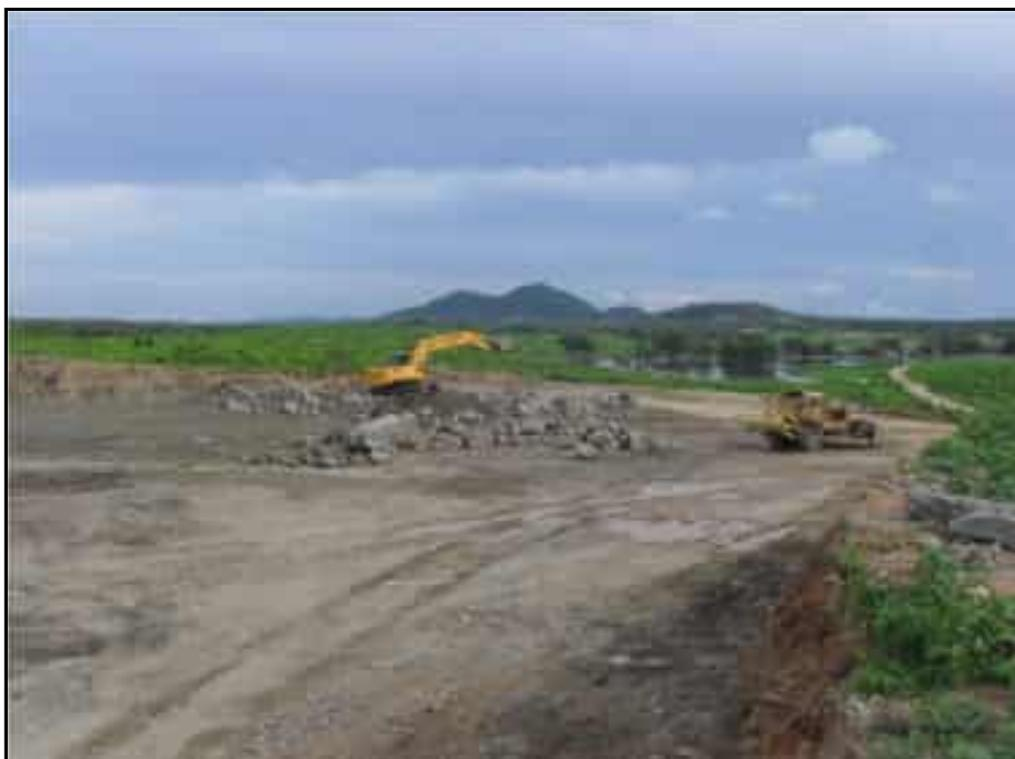
**Foto 04** – Vista dos serviços de escavação mecânica no lado montante do sangradouro.
