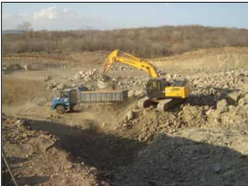
**Foto 01** – Escavação de material de 3ª categoria do vertedouro.
