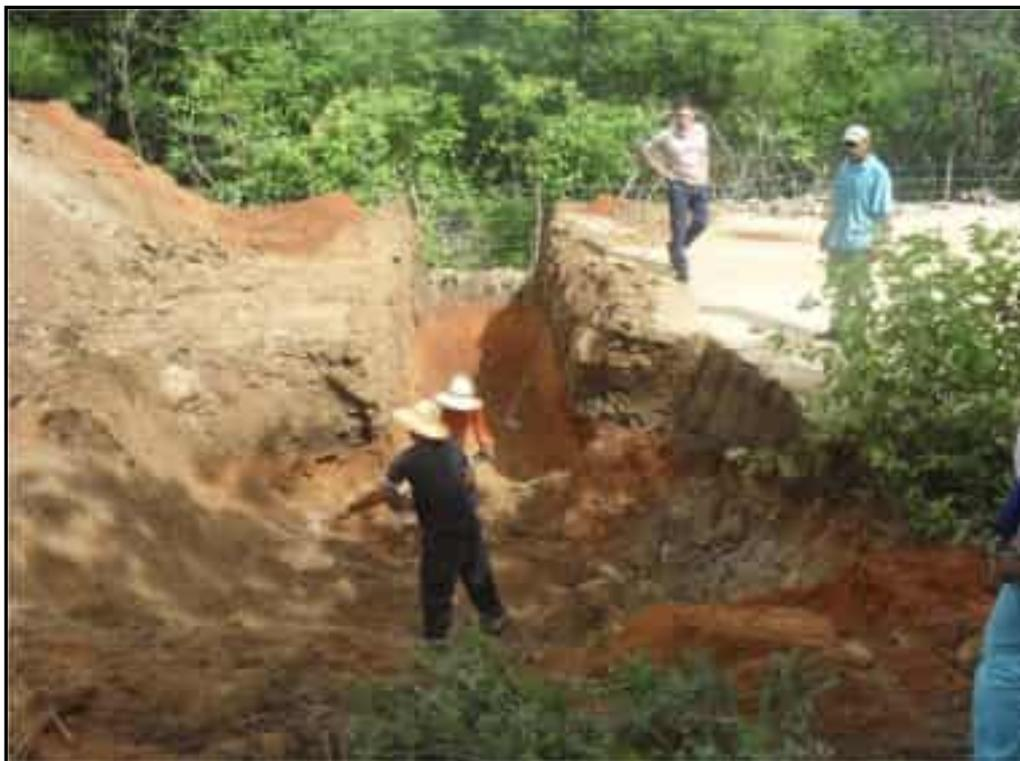
**Foto 06** - Vista da escavação para implantação do corpo de bueiro simples de diâmetro de 800mm na estrada de contorno entre a barragem e a cidade de Baixo/CE.
