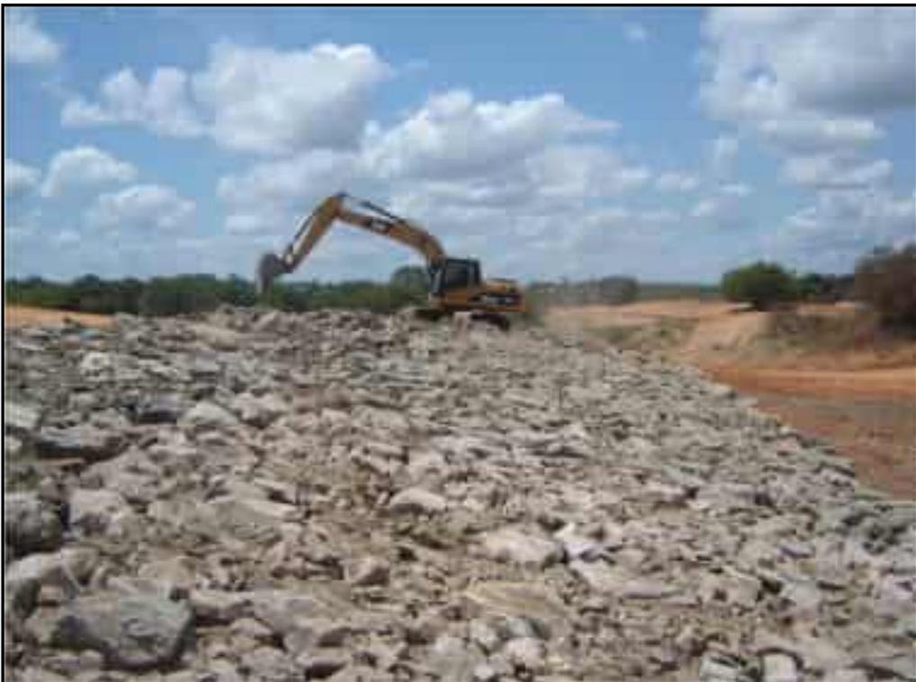
**Foto 28** – Execução dos serviços de proteção do aterro com enrocamento na abertura do maciço para escoamento das águas.
