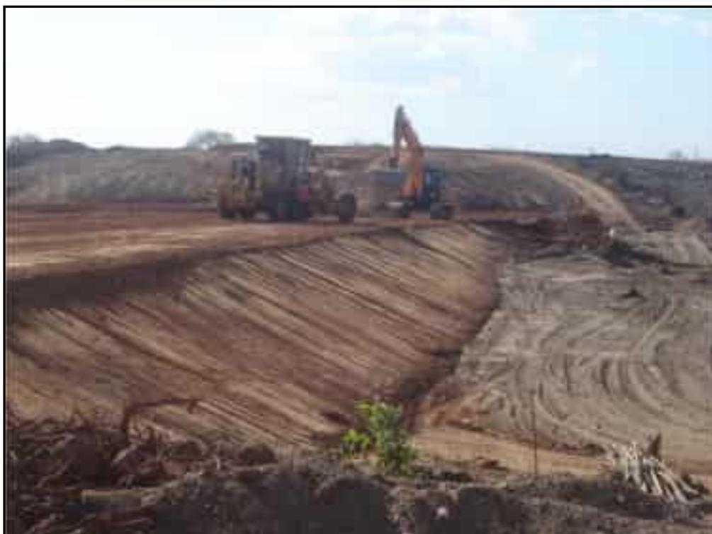
**Foto 06** – Execução do corte de rampa e regularização do talude de montante entre as estacas 14+0,00 e 20+0,00.
