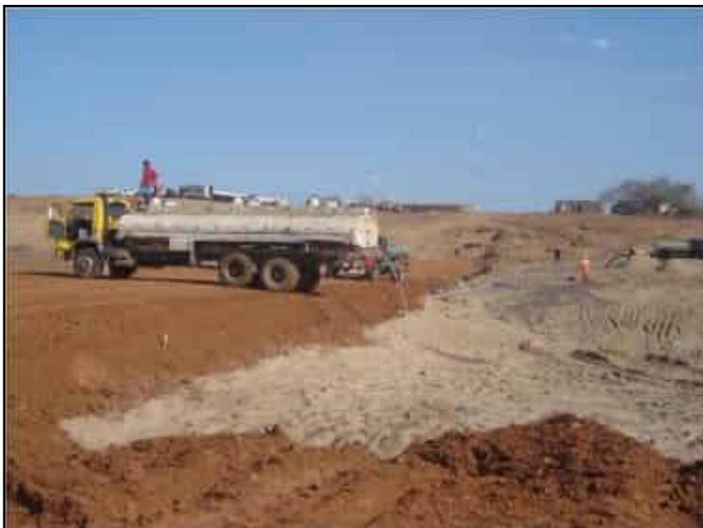
**Foto 02** – Adensamento do filtro horizontal entre as estacas 19+0,00 e 22+0,00.
