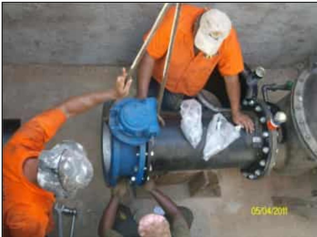
**Foto 15** – Vista do serviço de montagem da válvula borboleta da Tomada D'Água.
