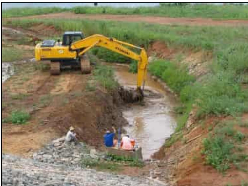
**Foto 17** – Limpeza do canal de aproximação da tomada d'água.
