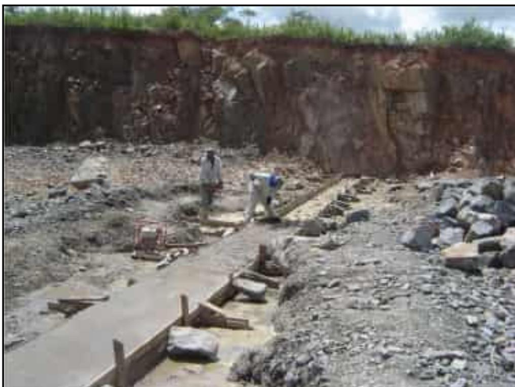
**Foto 10** – Aplicação de concreto ciclópico no cordão de fixação do Sangradouro, regularizado na cota 260,00.
