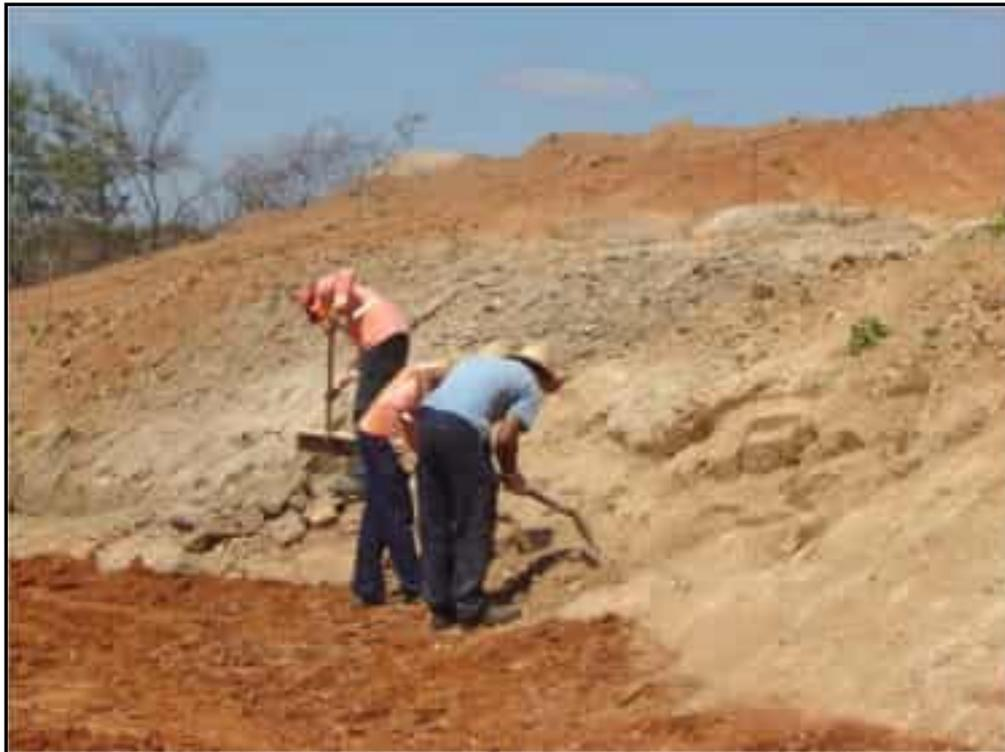
**Foto 11** – Limpeza manual na rocha de fundação para execução do aterro compactado na estaca 14+0,00.
