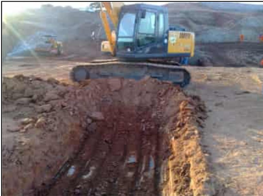
**Foto 45** – Abertura de poço de inspeção na estaca 17+0,00 para verificação da qualidade do aterro.
