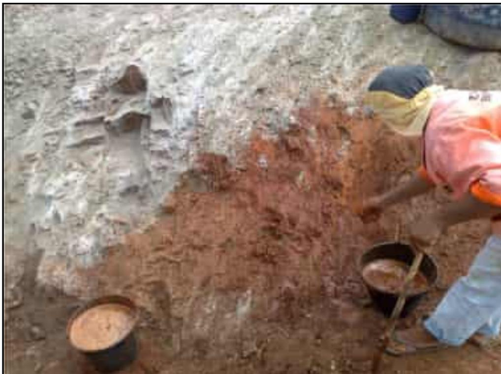
**Foto 44** – Preparação da rocha com calda de argila para execução do aterro.
