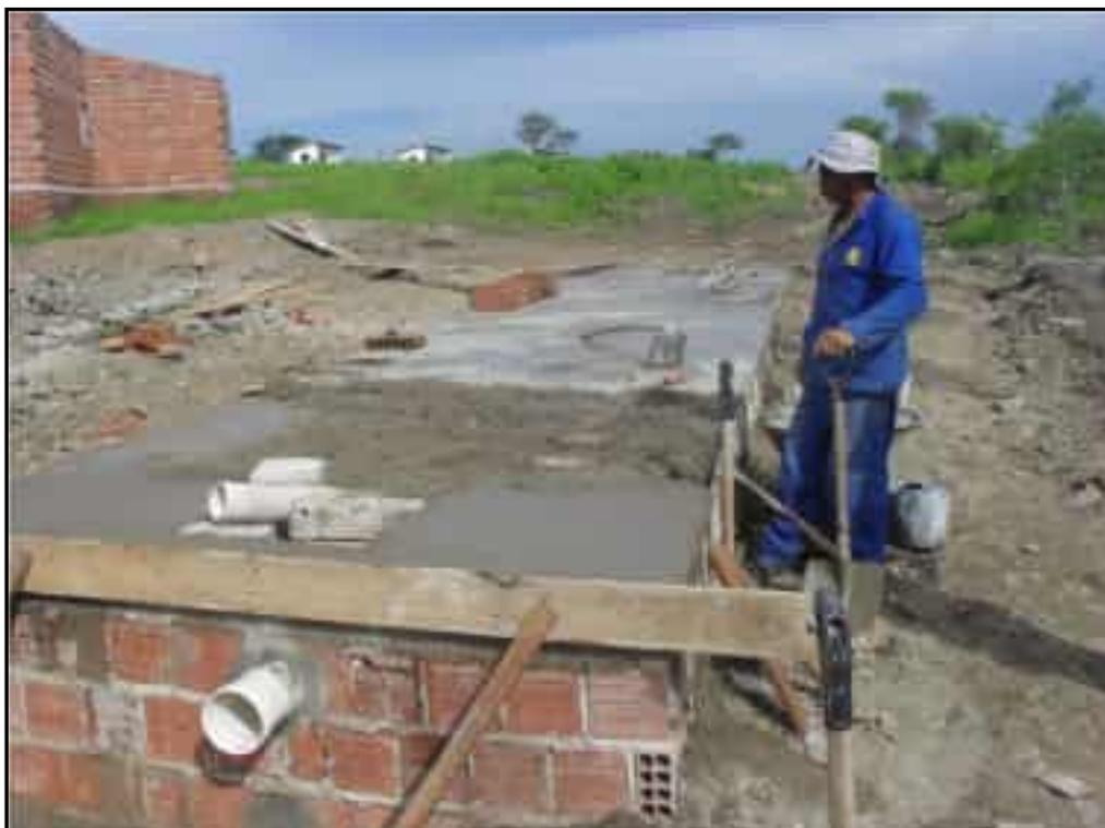
**Foto 14** – Vista do serviço de concretagem da laje de cobertura na primeira fossa séptica.
