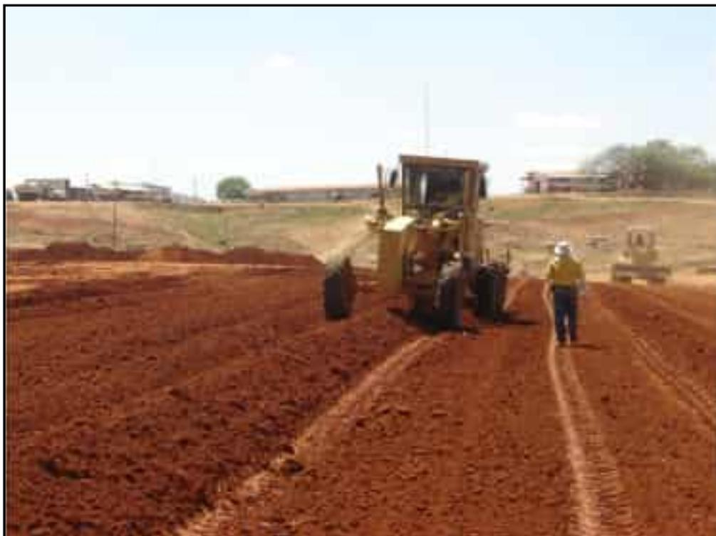
**Foto 09** – Tratamento e preparação do material argiloso para compactação da camada.
