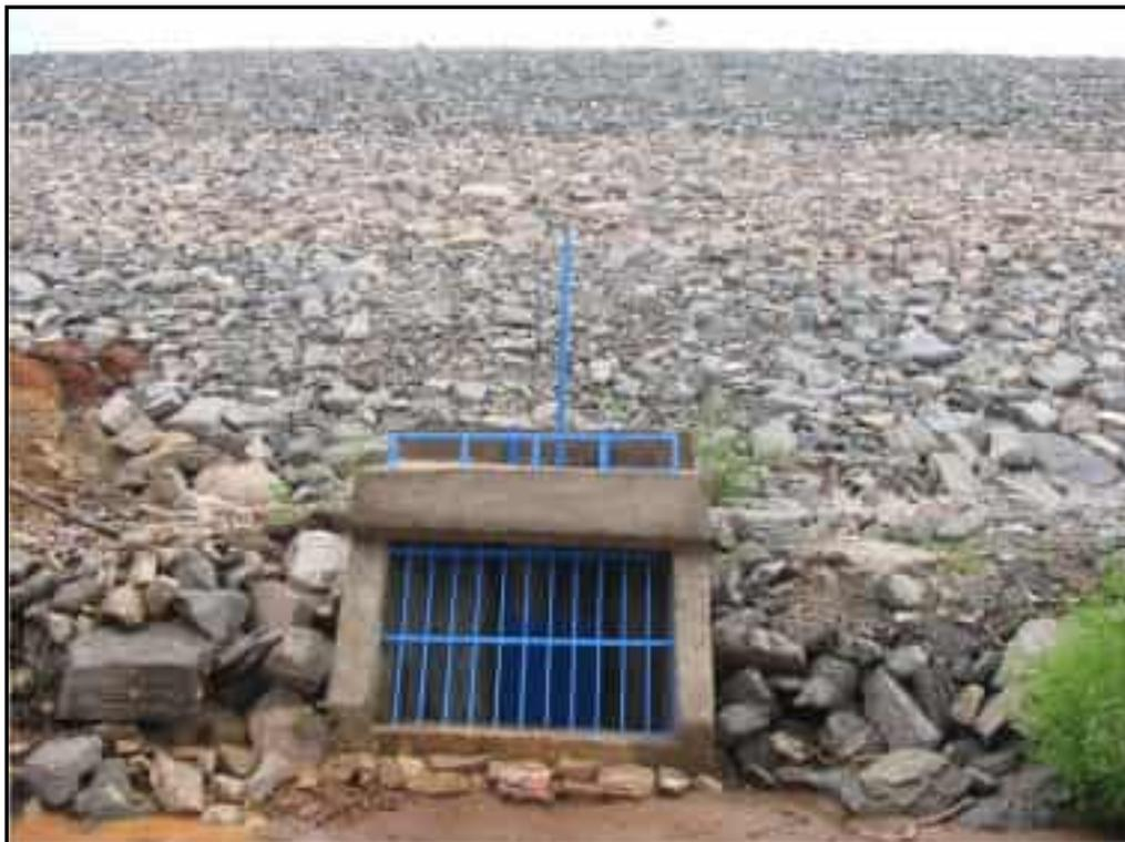
**Foto 19** – Vista da caixa de jusante da tomada d'água com a grade, stop-log e by pass instalados.
