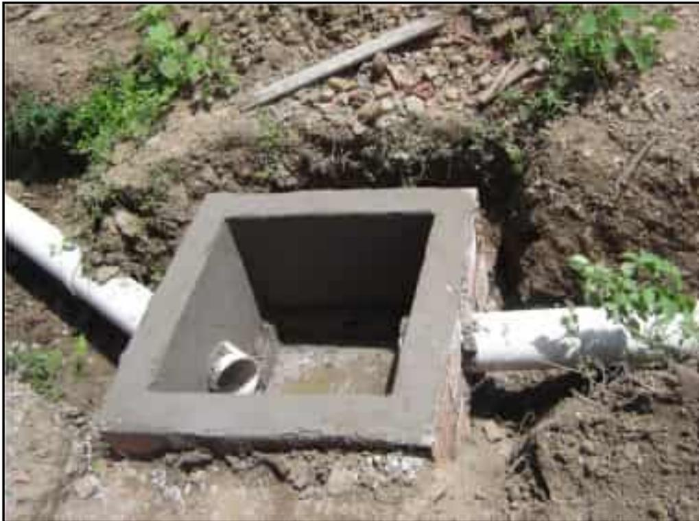
**Foto 19** – Construção de caixa de passagem da rede de esgoto na agrovila.
