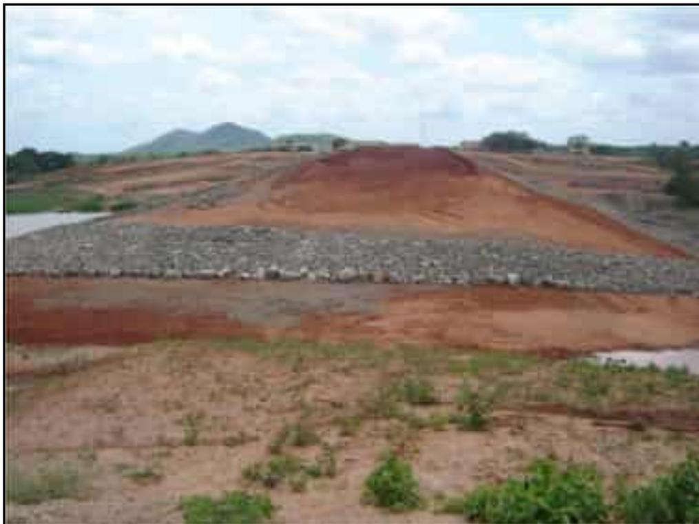
**Foto 29** – Vista do enrocamento executado no sentido transversal ao eixo da barragem para proteção do maciço.
