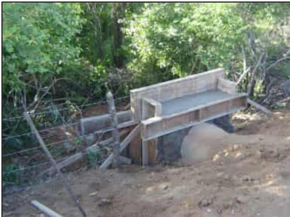
**Foto 07** – Vista da construção de boca de bueiro simples com diâmetro de 800mm na estrada de contorno entre a barragem e a cidade de Baixo/CE.
