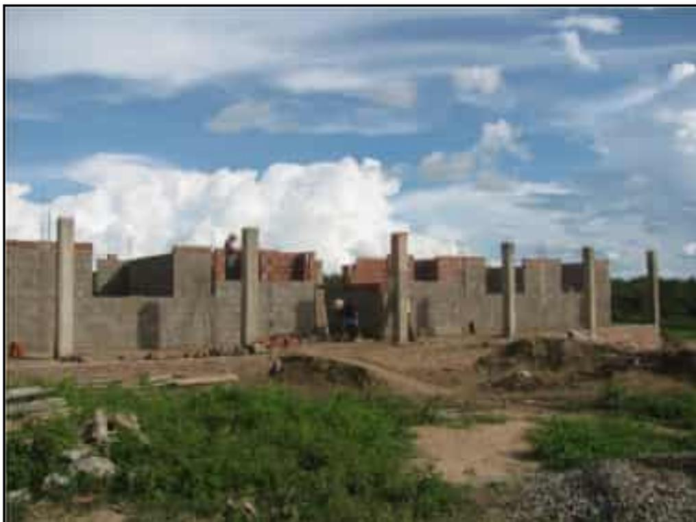
**Foto 23** – Construção do grupo escolar na Agrovila e em detalhe a execução da alvenaria de elevação.
