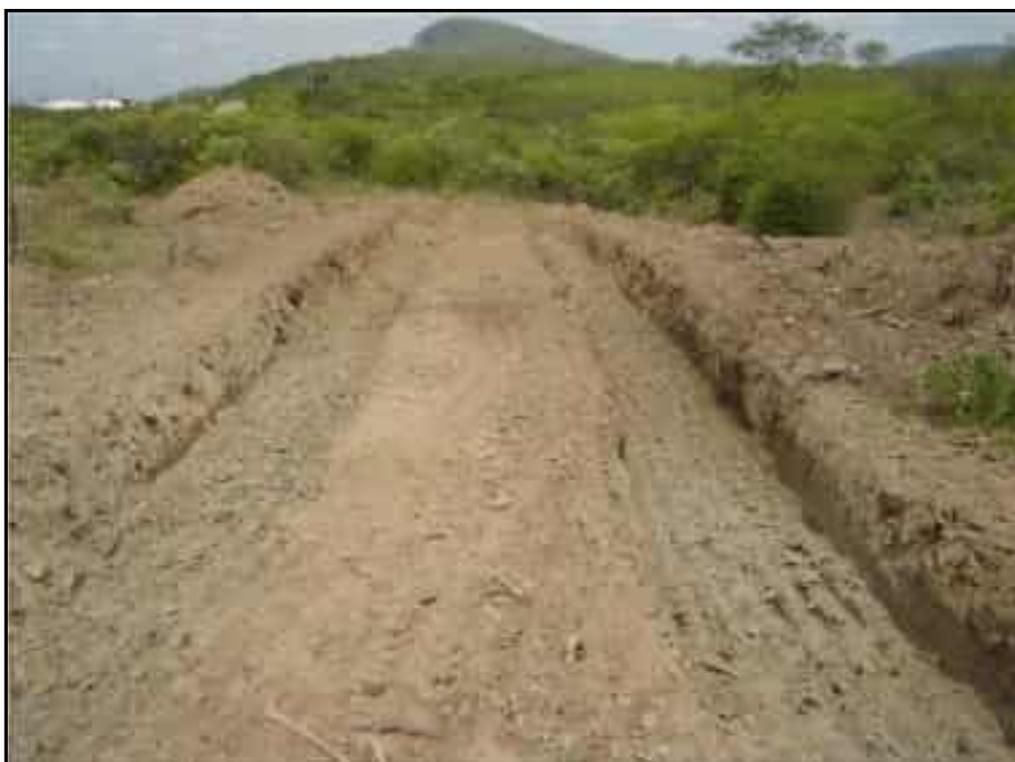
**Foto 08** – Escavações para construção das valas de infiltração (sumidouros) na agrovila.
