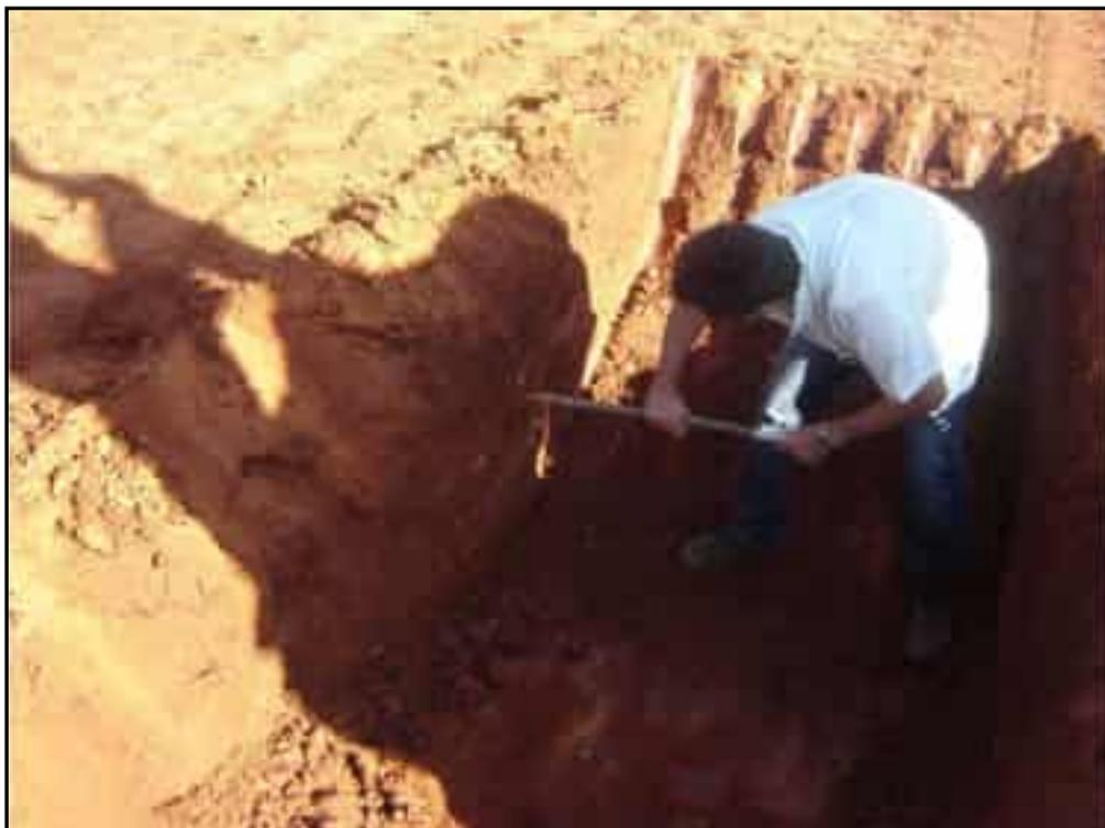
**Foto 17** – Verificação do aterro pela equipe de supervisão no poço de inspeção, onde foi verificada a boa qualidade do aterro no tocante a compactação, homogeneidade e umidade.
