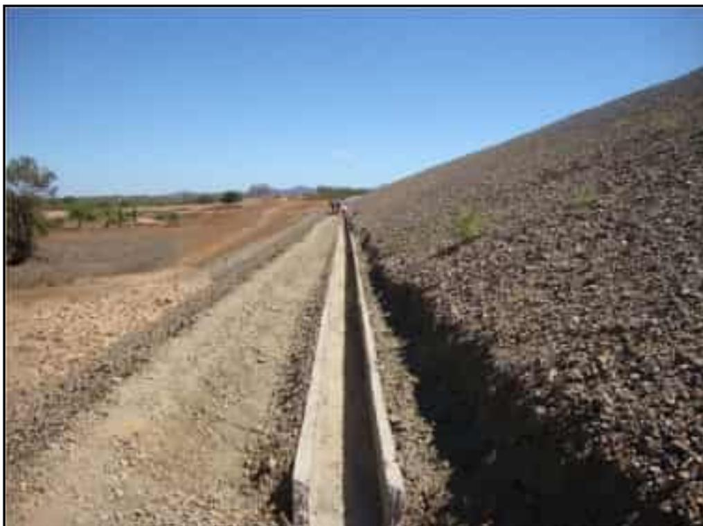
**Foto 67** – Vista longitudinal da calha de drenagem na berma.
