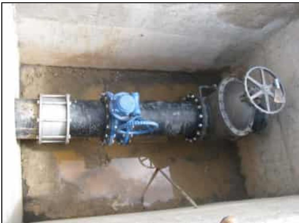
**Foto 16** – Equipamentos hidromecânicos da Tomada D'Água.
