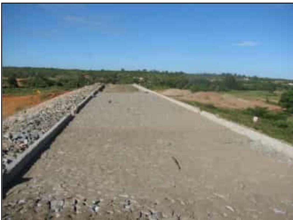
**Foto 52** – Vista da pavimentação em pedra tosca na estaca 8+0,00.
