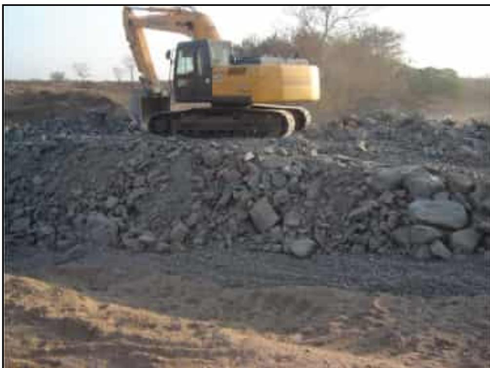
**Foto 08** – Execução do “rock-fill” na estaca 20+0,00, com detalhe para as zonas 7 (areia), 4 (brita) e 9 (enrocamento).
