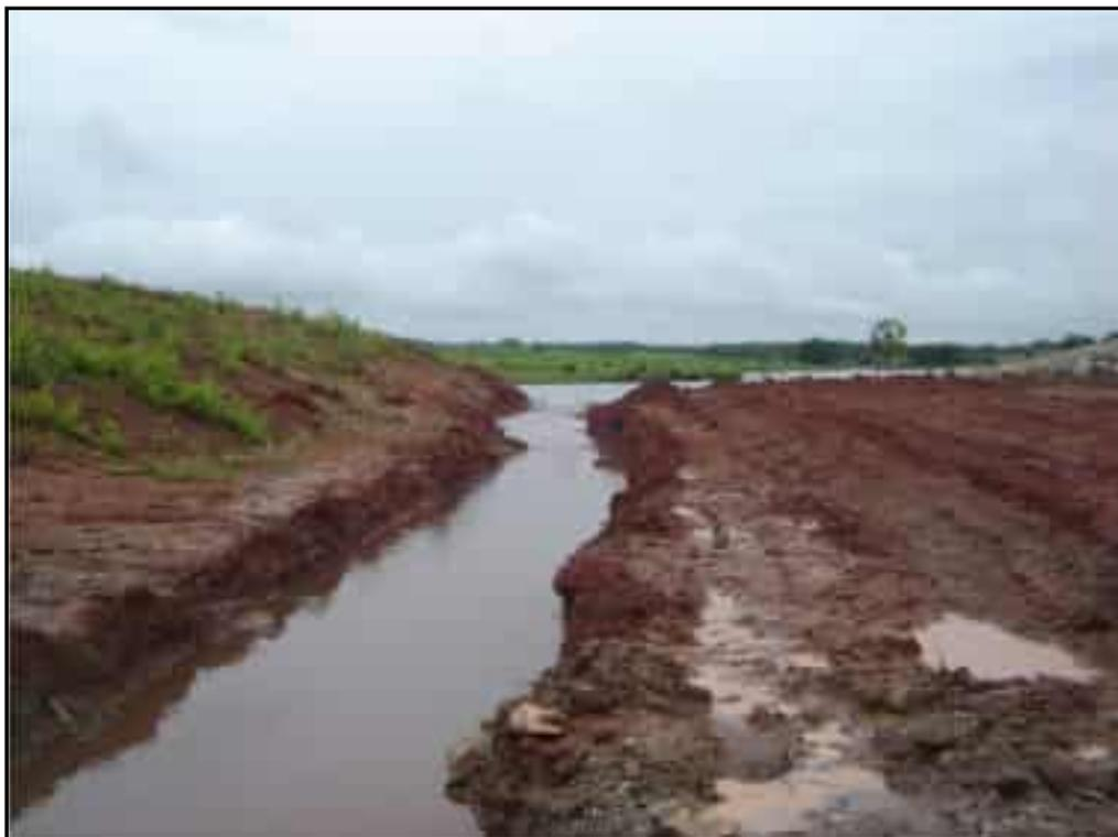
**Foto 31** – Início do escoamento das águas da bacia hidráulica pela abertura no maciço na estaca 14+0,00.
