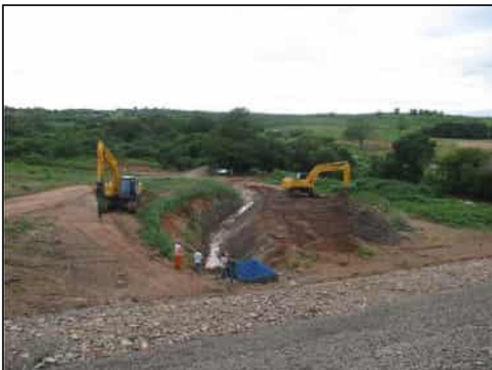
**Foto 18** – Limpeza do canal de dispersão da tomada d'água.
