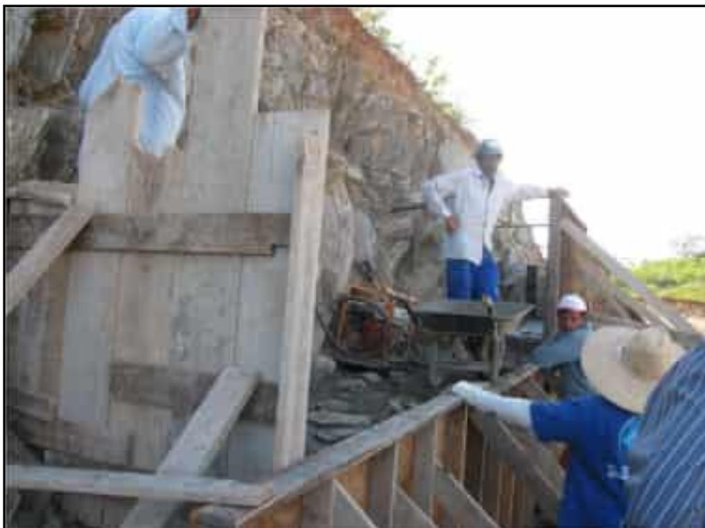
**Foto 15** – Execução do serviço de concretagem do muro lateral esquerdo do sangradouro.
