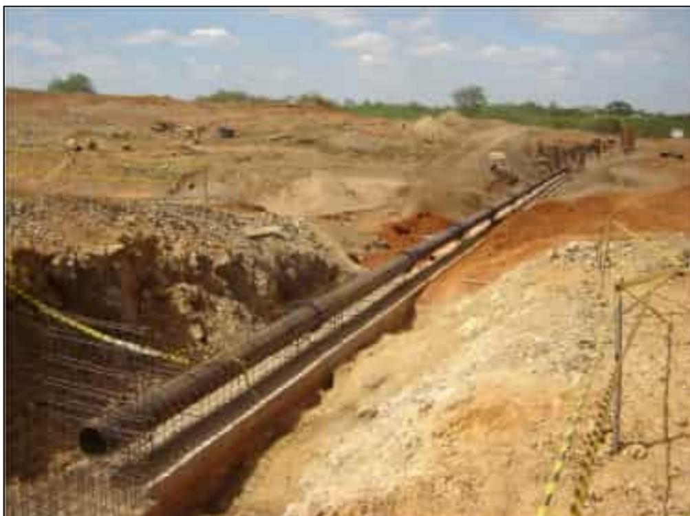
**Foto 06** – Vista dos tubos montados e assentados na galeria da Tomada D'água, estaca 24+0,00.
