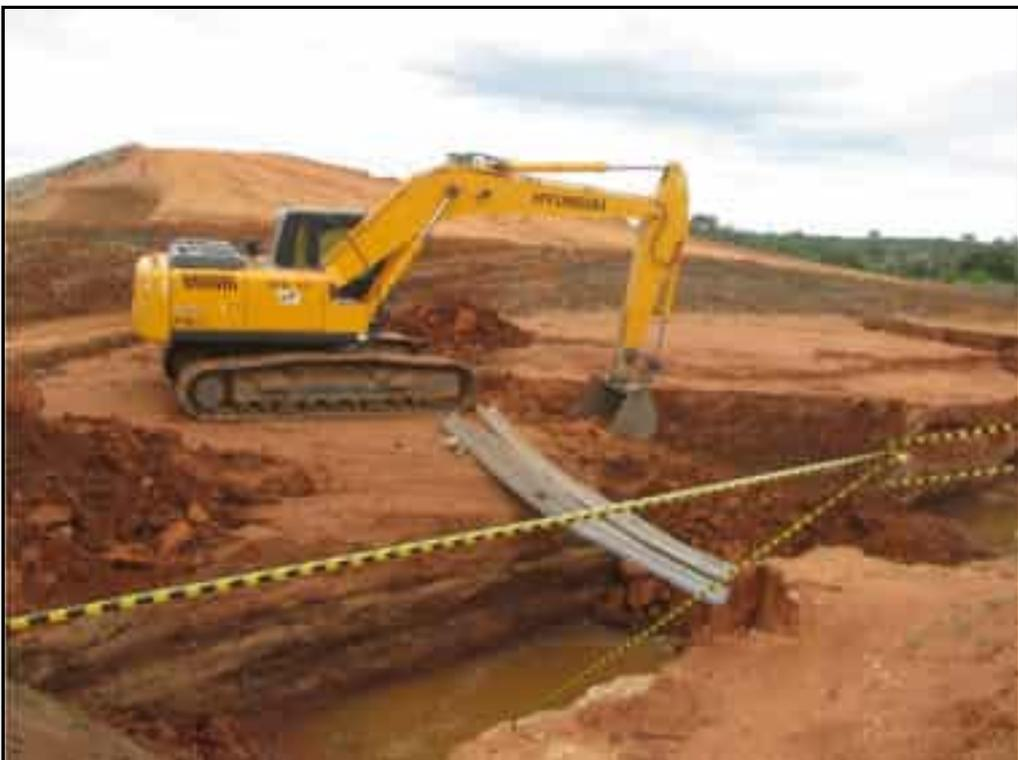
**Foto 40** – Escavação do maciço argiloso na estaca 13+10,00 para rebaixamento do nível d'água.
