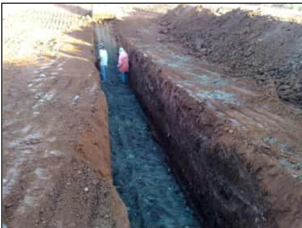
**Foto 48** – Abertura do filtro vertical entre as estacas 13+10,00 e 14+10,00.
