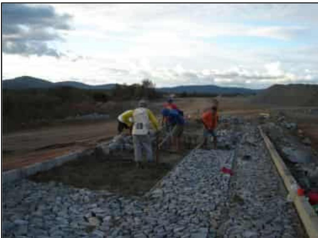
**Foto 58** – Execução da pavimentação em pedra tosca entre as estacas 01B+0,00 e 09A+0,00.
