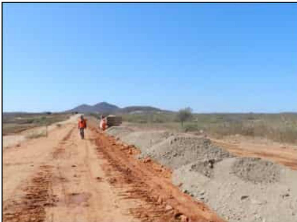
**Foto 65** – Execução do filtro horizontal entre as estacas 14E+0,00 e 23E+0,00.
