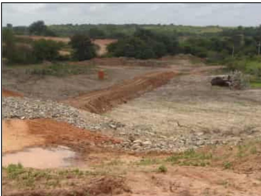
**Foto 30** – Vista da enseadeira executada a jusante da abertura no maciço para proteção do aterro compactado e “rock-fill”.
