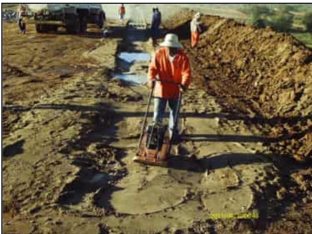
**Foto 50** – Execução da compactação mecânica da areia do filtro vertical.
